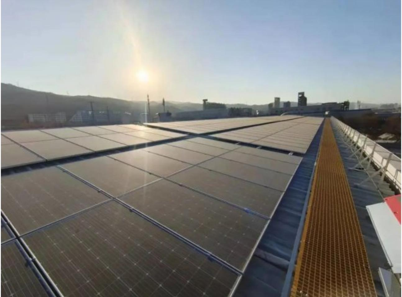
西宁分公司多功能BIPV项目集屋顶光伏、地面光伏、幕墙光伏、光伏车棚等多应用场景下的“绿色、清洁、低碳”综合智慧能源网，包含100千瓦多功能BIPV光伏幕墙、157.76千瓦常规组件光伏幕墙、179千瓦光伏智慧停车场、4.783兆瓦屋面分布式光伏系统，总计可年发绿电540万千瓦时，减少二氧化碳排放5388吨。
