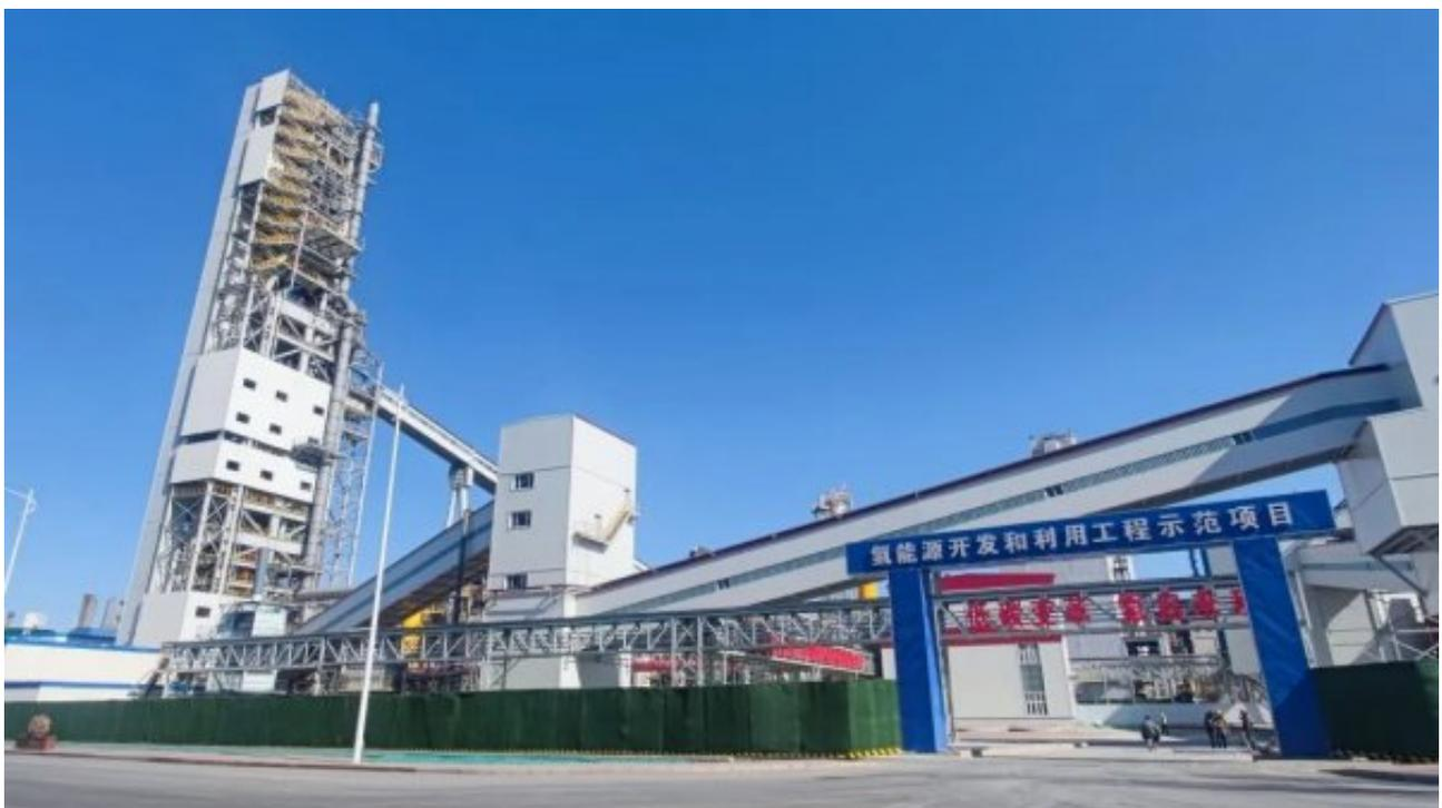
河钢张宣科技氢冶金项目开发的氢还原新工艺，凭借自主创新和集成创新，全球首次开发和实施“焦炉煤气零重整竖炉直接还原”工艺生产绿色高纯铁技术。该项目利用焦炉煤气本身含有60%左右的氢气作为主要还原气，同时应用先进的零重整技术，将其20%左右的甲烷进一步分解为一氧化碳和氢气，使还原气体中的氢碳比达到8:1以上。
