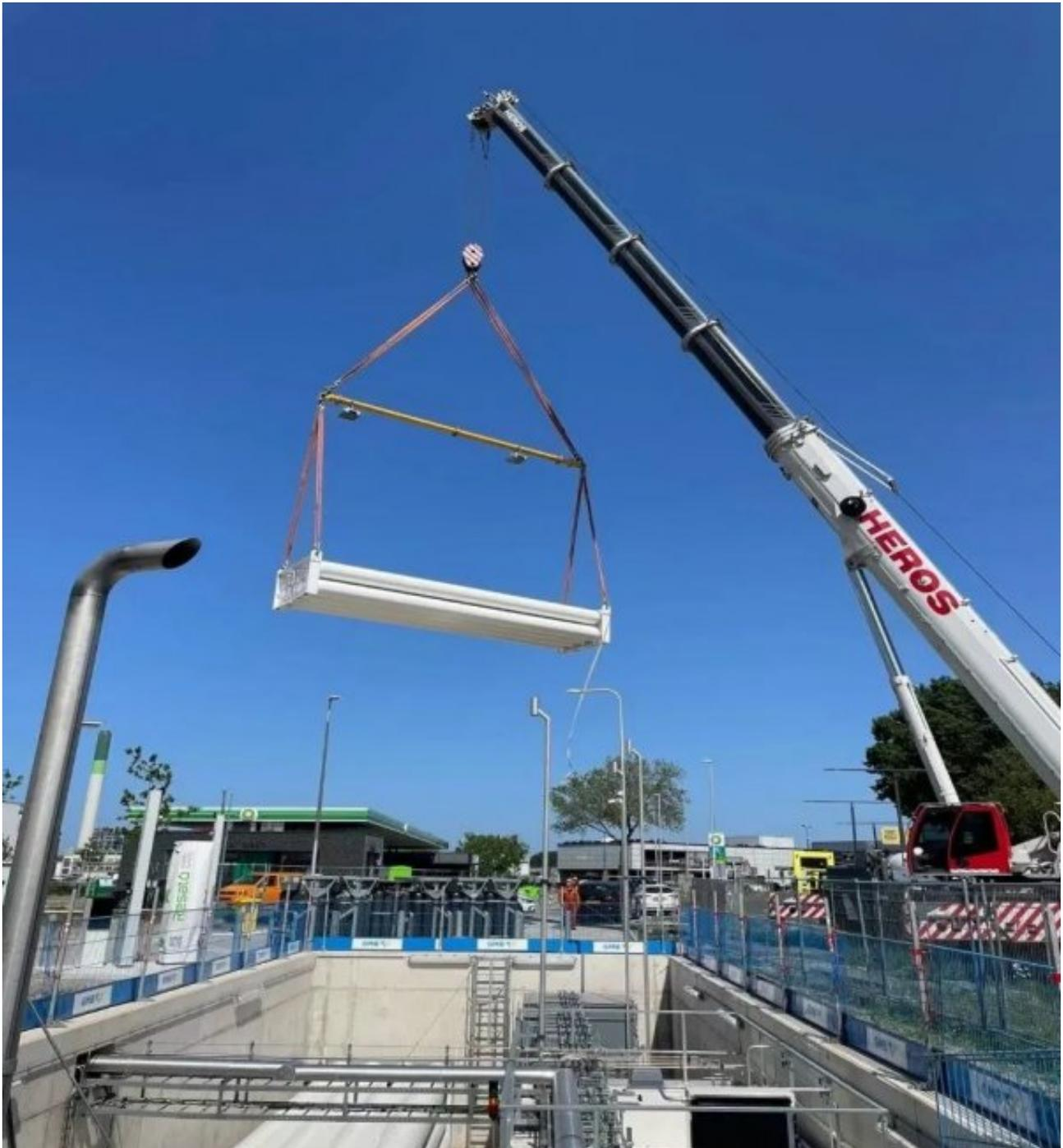
该加氢站是业主方在荷兰各地的物流中心配套的清洁能源中心，是使用清洁能源代替传统化石能源战略目标中的重要一环。项目使用的储氢容器、压缩机等部件全部放置于地下，并用钢板包围。项目将搭配一个用于卡车和公共汽车的350bar加氢机，以及一个用于乘用车的700bar加氢机。
