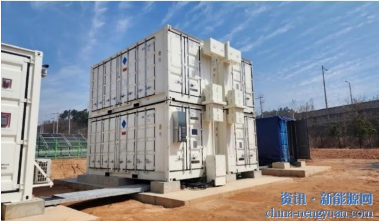
罗州韩电试验场的集装箱NAS电池储能系统。图片：NGK Insulators
