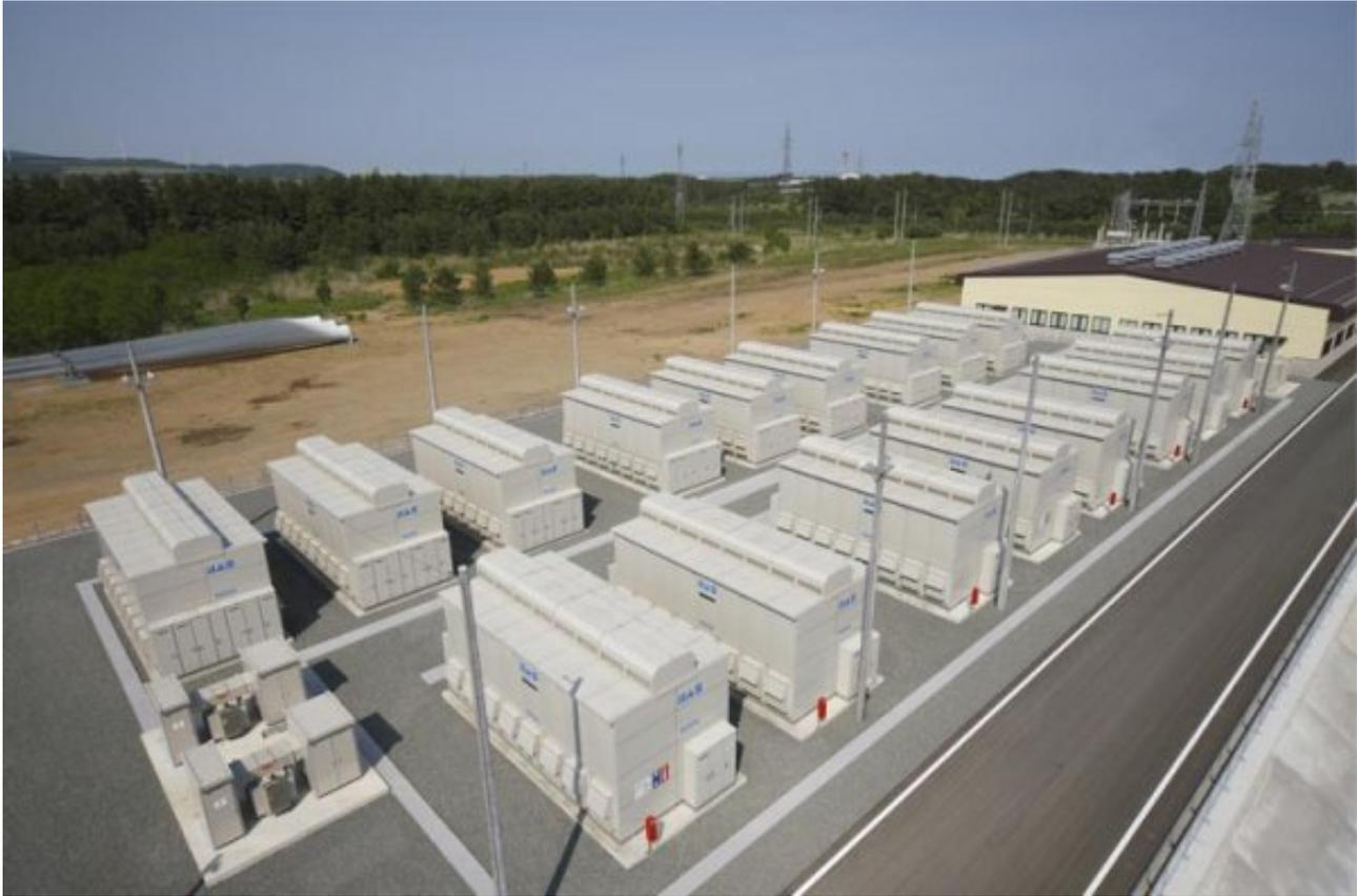
从在290 ° C-360 ° C温度范围内工作的1.2kWh电池单元，堆叠到模块和机架中，然后放入20英尺的集装箱中，每个集装箱最大输出250kW，能量容量1.45MWh，最多可以堆叠四个集装箱，以提供MW级解决方案。
