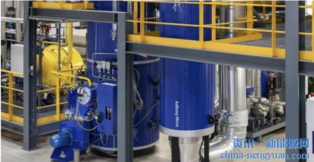
总部位于瑞典的阿法拉伐公司(Alfa Laval AB)是一家传热、分离和流体处理产品的全球供应商，近日宣布扩大其船舶领域替代燃料解决方案组合，推出以甲醇为燃料的奥尔堡锅炉系统（Aalborg boiler systems），该系统提供燃料灵活性，可适应包括甲醇、生物质燃料在内的多种燃料类型。
