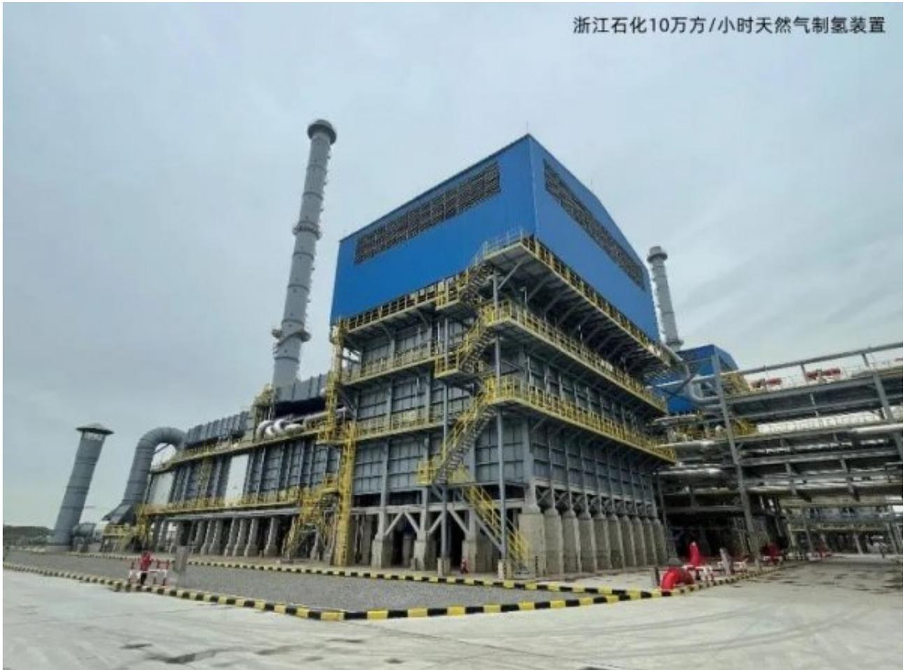
据悉，该装置采用预转化+一段转化的工艺技术，其中预转化反应器装填了西南院提供的新一代CN-14R型预转化催化剂，该催化剂结构稳定，抗积碳性强，且为预还原型催化剂，冷态开车时间小于10小时，投料后不到半小时反应即达到工艺设计要求，出口工艺气甲烷含量降至~73%，C2以上高烃小于0.1%，极大的缩短了装置开车时间，为业主节省了大量开车费用。
