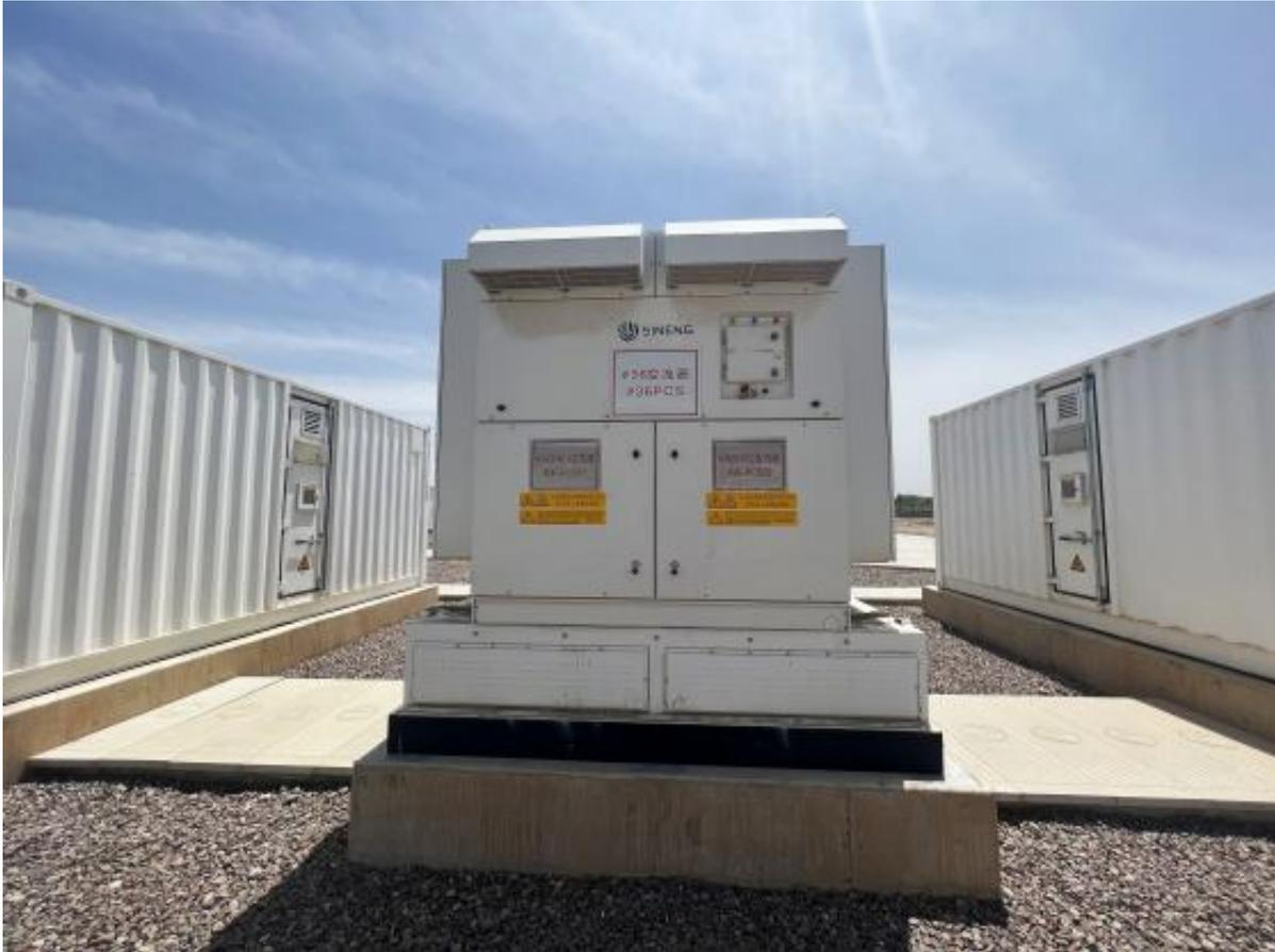
项目地处戈壁，多风沙、极温、日夜温差大等环境挑战对设备性能提出了极高的要求。上能电气为项目提供的3.15 MW集中式储能变流一体机，具备-30 ~ 60 宽温工作能力，高安全、高防护设计确保电站运营表现更优。同时兼具毫秒级响应速度、黑启动功能等优势，可实现共享储能充放电更快、更好支撑电网稳定运行。凭借更高效、更佳经济性、更强可靠性等特质，上能电气集中式储能产品全球累计应用超过3GW，足迹遍布高海拔、高盐雾、沙戈荒等场景，持续领航大储时代！
