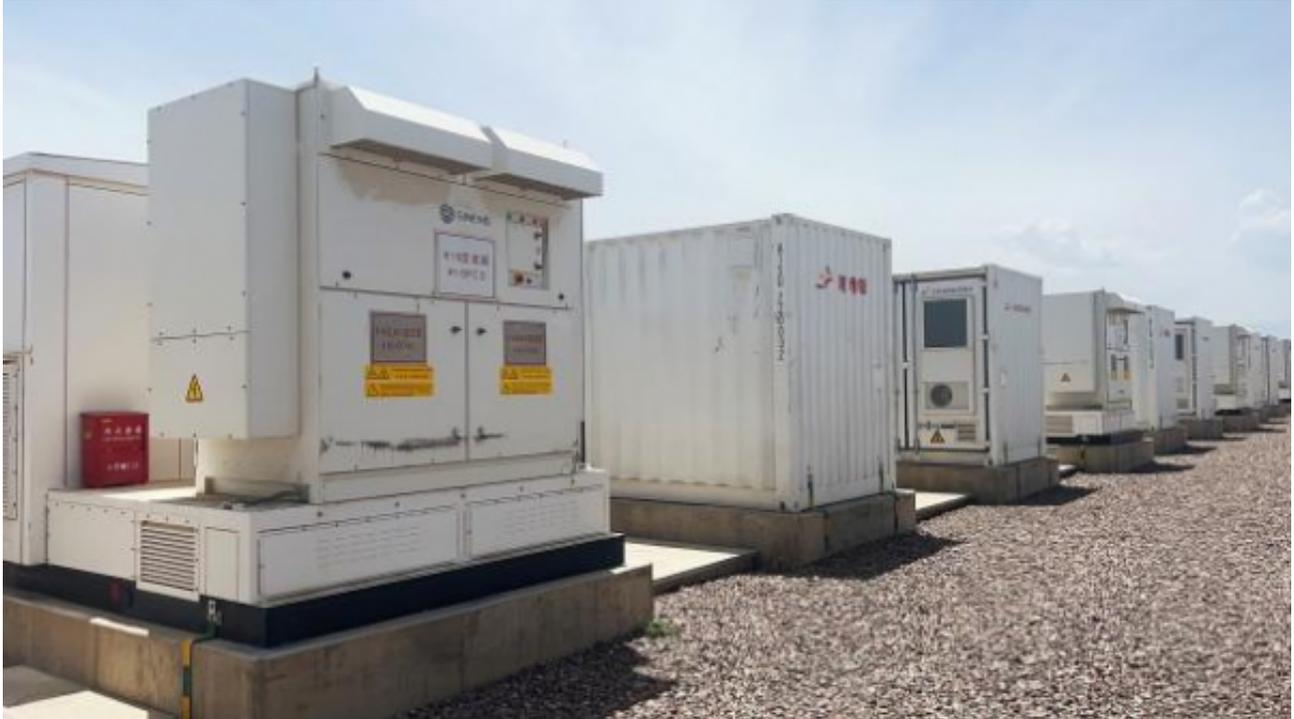
该项目总容量为500MW/1000MWh，占地156亩，总投资23亿，共分两期建设。其中已投运的150MW/300MWh一期工程，共包含50套3MW/6MWh储能单元，PCS系统全部采用了上能电气集中式大型储能方案，是甘肃单体规模最大的电网侧独立共享储能电站。
