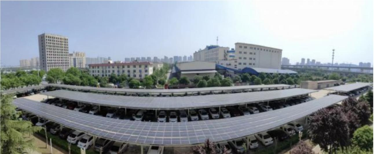
咸阳宝石光伏项目位于陕西省咸阳市秦都区，总装机容量12.5兆瓦，主要利用咸阳宝石钢管钢绳有限公司生产厂房屋面建设屋顶分布式光伏，装机容量11.55兆瓦；在厂区停车场建设0.95兆瓦光伏车棚，配套建设18个交流、2个直流智能充电桩。
