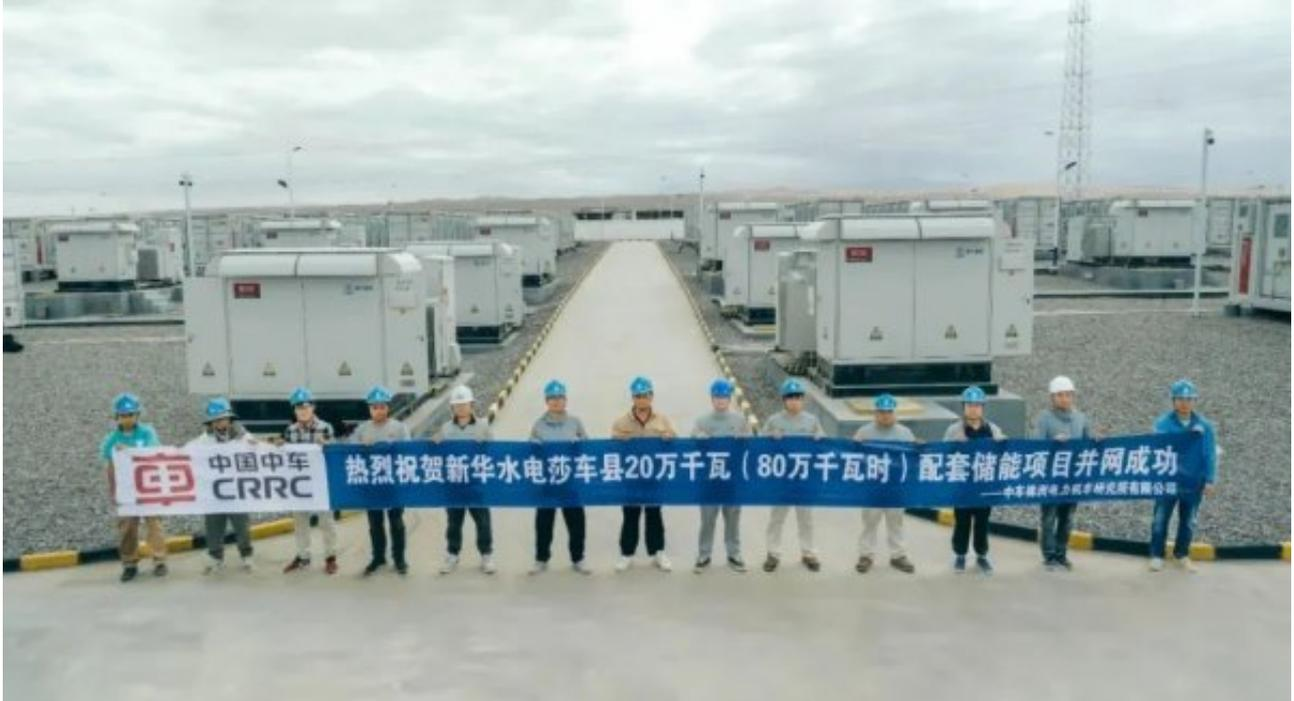
该储能电站位于新疆莎车县光伏发电园区内。中国中车提供的储能系统由77个2.6MW/10.4366MWh（9.691MWh）磷酸铁锂电池储能子单元组成，包含77个变流升压舱和154个储能电池舱。多套磷酸铁锂电池储能子系统的升压变压器35kV侧，采用手拉手接线汇集为1回35kV储能汇集线，储能电站分多回储能汇集线接入220kV汇集站的35kV母线。
