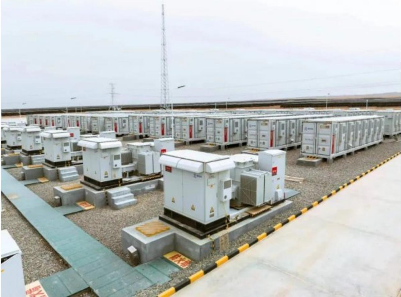
储能电站应用了先进的系统控制技术，支持海量数据和设备接入，可实现“毫秒级”快速功率及协同控制。在安全方面，通过高稳定性和高安全性系统设计，在极端故障情况下，可保障数据存盘安全；采用基于大数据的故障预测与健康健康管理，对电池进行全生命周期管理，能有效识别异常、诊断故障、提前预警及维护。同时，在消防安全上应用多级安全保障技术，精准探测烟雾和温度变化，进行多级报警、自动灭火和联动灭火。
