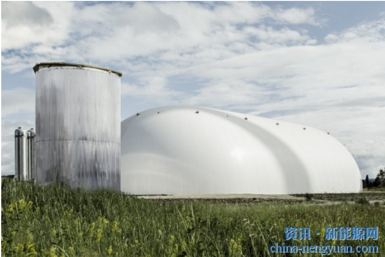
意大利撒丁岛的一个商业示范设施中的Energy Dome二氧化碳电池。
