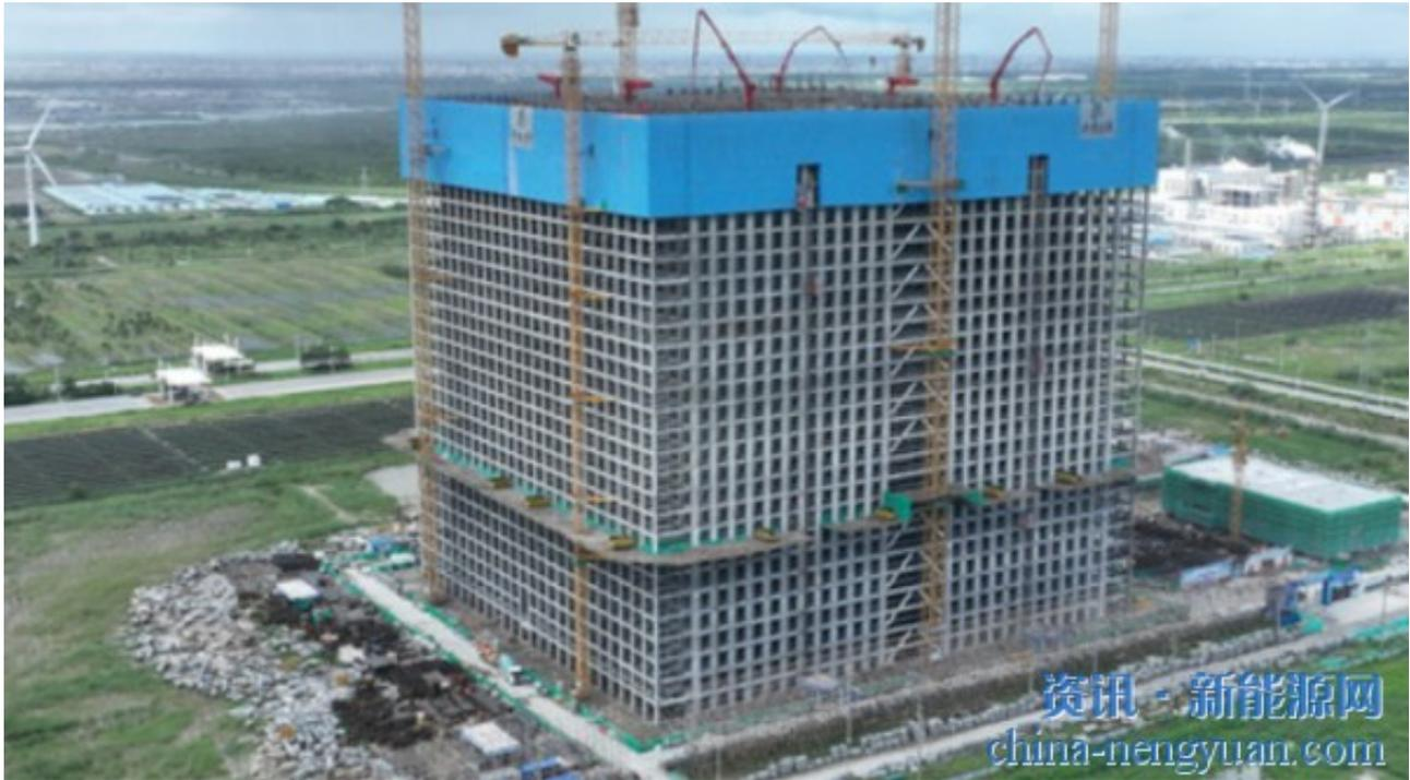
重力储能解决方案提供商Energy Vault宣布，全球首个电网规模重力储能系统EVx已在中国江苏省进入第一阶段调试。
