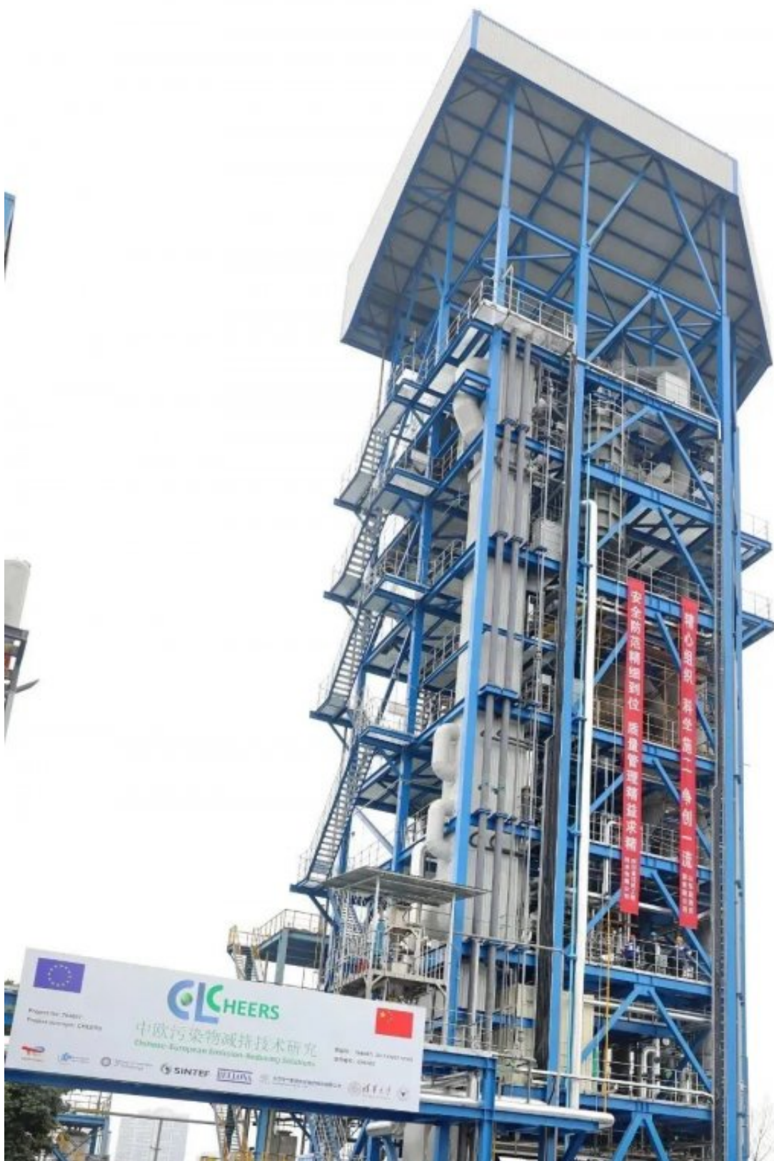
东方锅炉建成全球最大4兆瓦化学链燃烧示范装置，这是加强“双碳”领域技术创新的重要科技成果，是全球性碳捕集标杆创新技术，标志着中欧碳减排技术项目朝着工业化大规模脱碳应用更近了一步。
