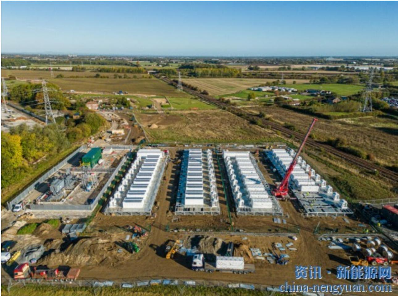
Harmony Energy在英国东约克郡的196MWh Pillswood BESS建造在一个凸起的平台上，以减轻洪水易发地区的破坏风险。图片：Harmony Energy
