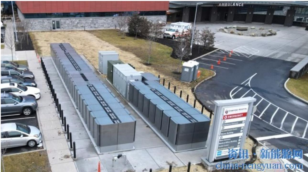
一种利用固体氧化物燃料电池(SOFC)固有高温的创新加热和冷却系统已经被开发出来。新获得专利的“综合吸收式加热和冷却系统”利用燃料电池的余热，提供了一个更环保和高效的解决方案。
