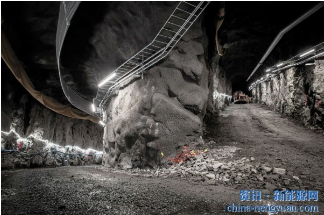
位于瑞典北部Luleå的地下岩洞氢储存设施。图片：Hybrit
