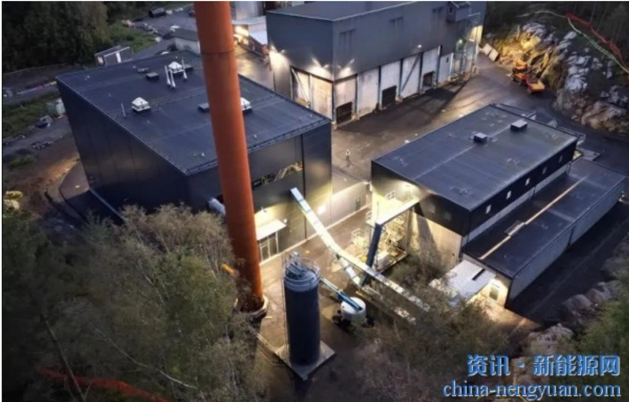
Againity向Kung älv Energi提供了一个最大功率为560KW的自动化ORC系统。该系统可以从锅炉的热水中产生电力，预计每年能够产生3080MWh。
