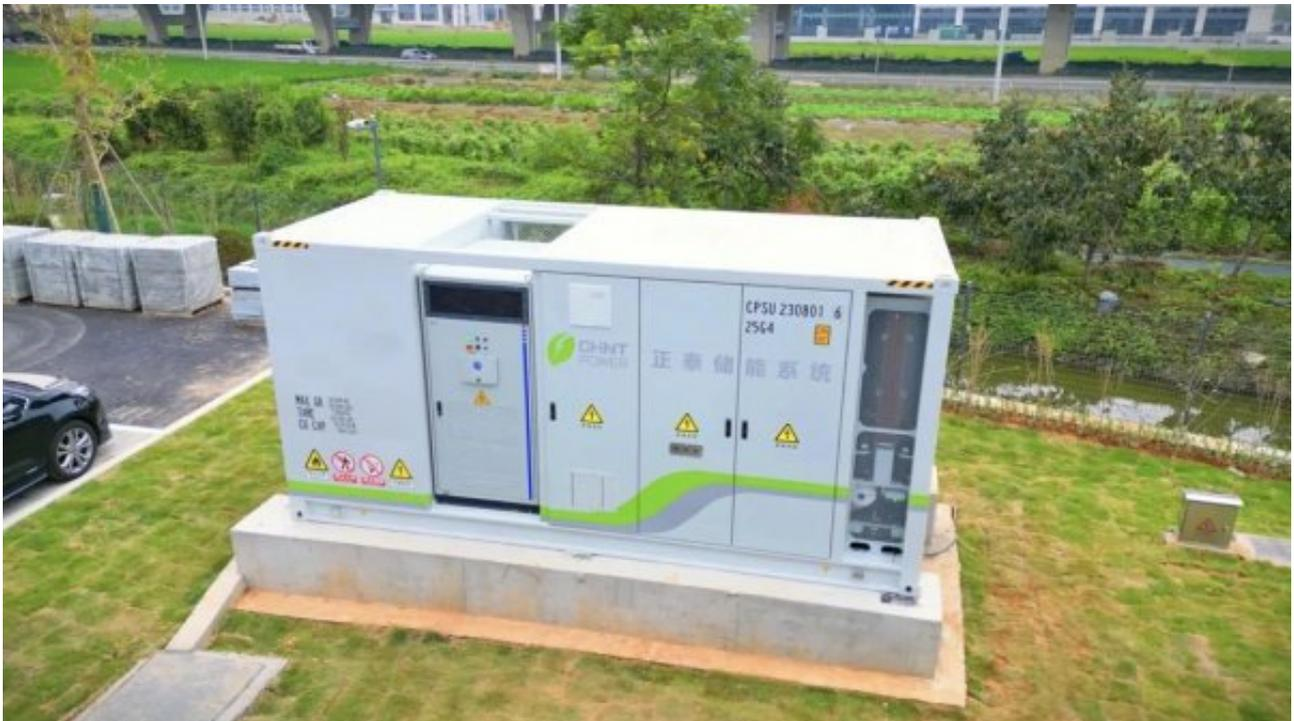
通过全面分析用户的用电需求后，正泰电源团队采用了电池+逆变器+变压器一体化的All-in-one架构集成设计，以满足用户在谷时具备足够的余量进行储能系统的充电，并在峰时完成电量的释放。
