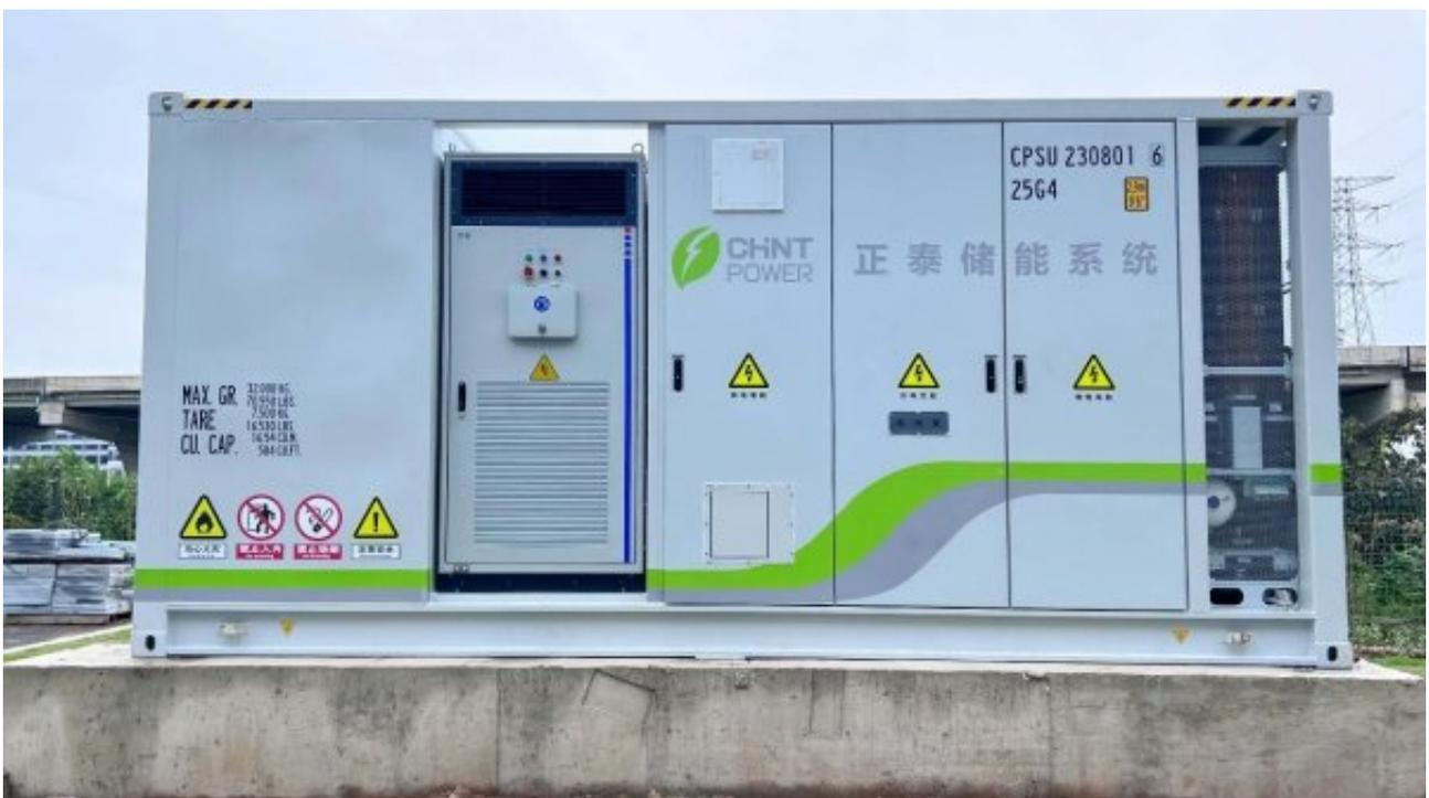
本项目使用的1.25MW/2.5MWh储能系统，不仅能减少用户的用电成本，还能通过峰谷套利实现一定的正向收益，
