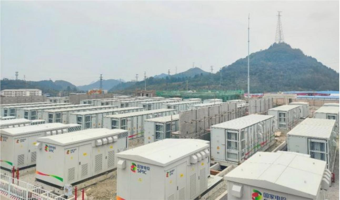
该批项目由国家电投贵州金元投资建设，总投资近30亿元，总装机规模900兆瓦/1800兆瓦时（最大充放电功率达900兆瓦，总储容量达1800兆瓦时），共7个储能电站，于7月20日全部开工建设。项目投运后，可提供90万千瓦的调峰能力。
