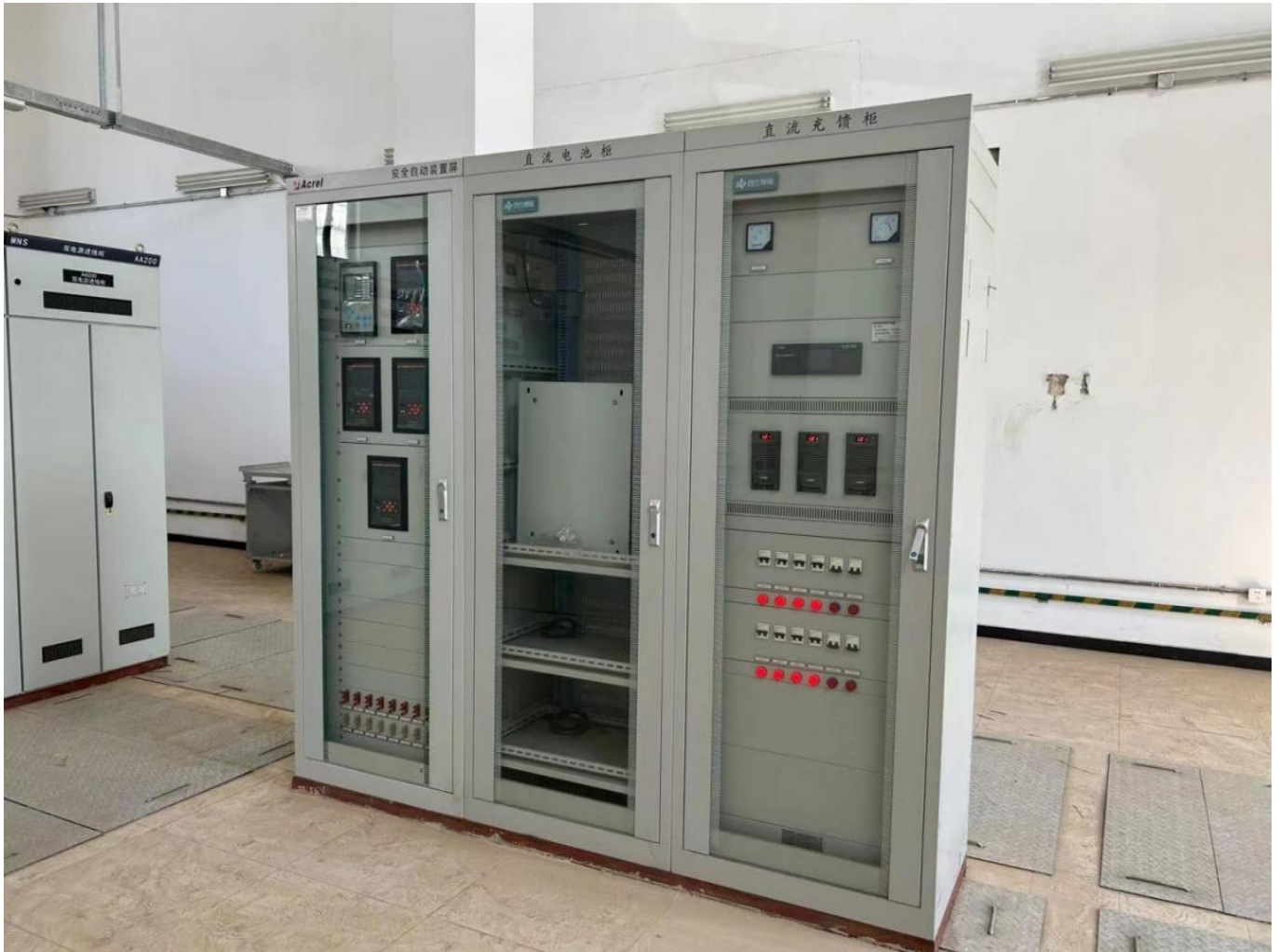
图4 装置就地和组屏现场安装图片
