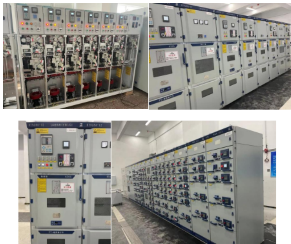
图3 微机保护装置以及电能表在贵阳万科翡翠滨江A1#楼配电项目现场安装图片
