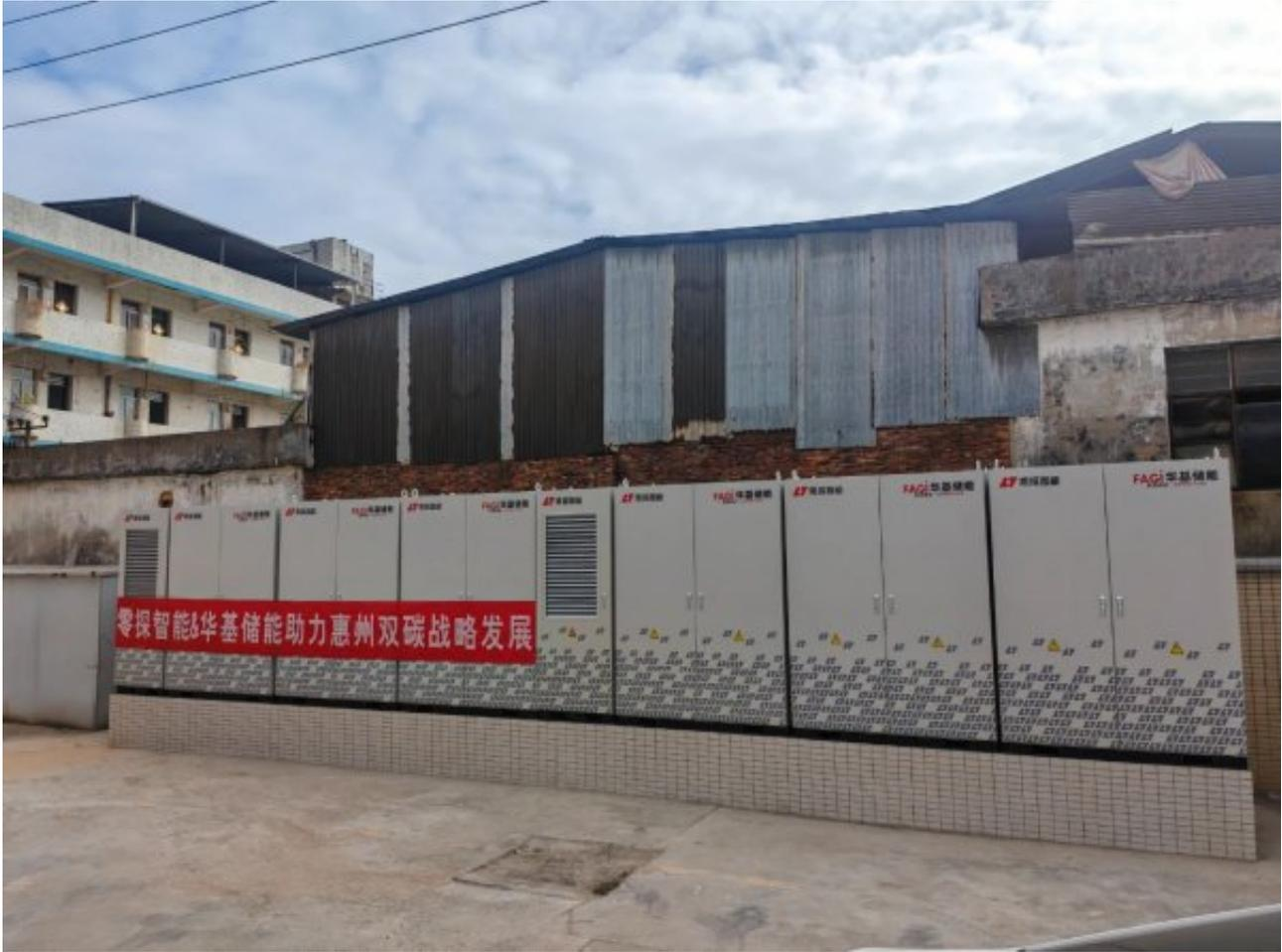
本期项目由6台零探智能Tensorpack T 215kWh/100kW分布式储能系统组成，总占地约13平方米。零探智能单台储能设备循环寿命可达8000次以上，双向循环效率高达91%以上，是业内超高的循环效率，可为工商业带来更高的经济收益。同时，产品采用多级电气及消防安全管控，电池安全预警大于10分钟，通过5项严苛的IEC国际认证，彰显了在安全、技术和质量标准方面的领先地位。
