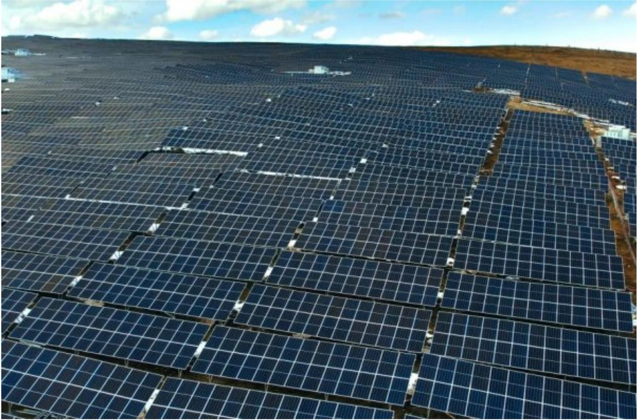
项目由39276个光伏组串、1727台逆变器、167台箱式变电站组成，覆盖面积超12000亩，采用“上层发电、下层养牛”的牧光互补建设模式。
