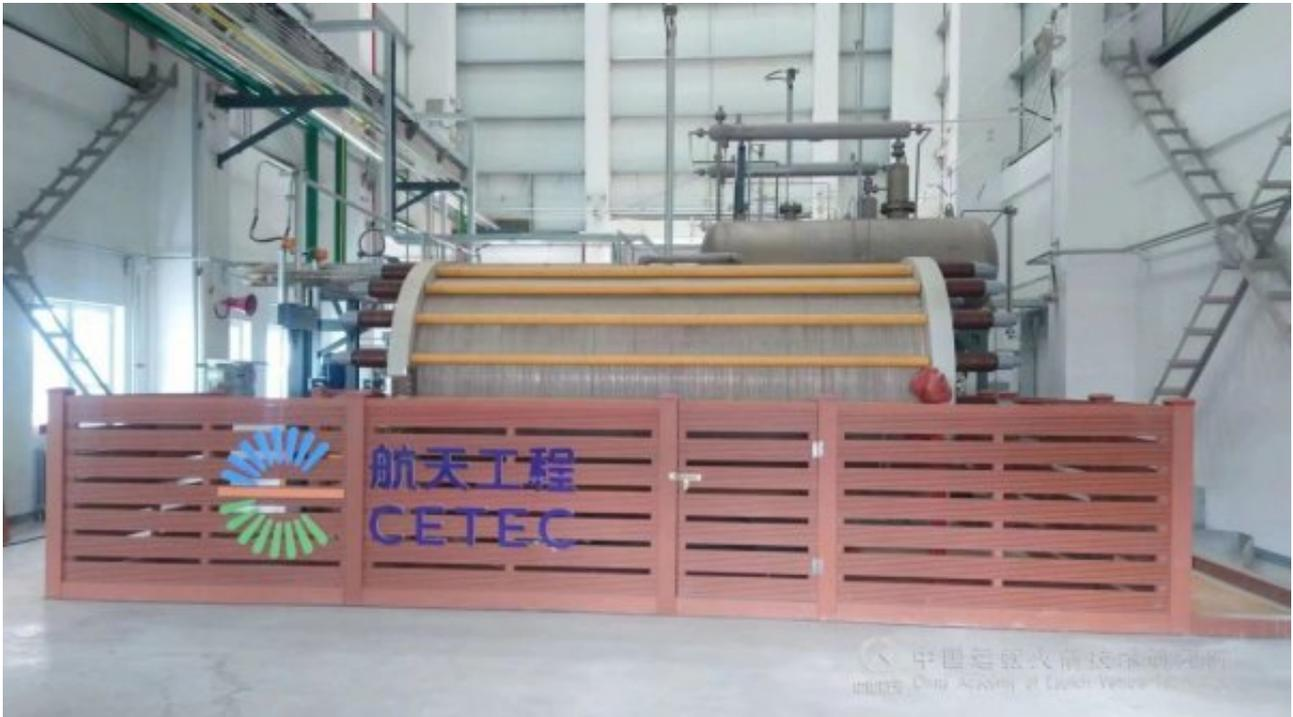
碱性电解水制氢技术，是航天工程公司依托中国航天在空间站生命保障技术上的成功实践，结合其多年来在化工领域的工程技术积累，孵化出的符合化工设计体系和安全评价等级的大标方碱性电解制氢装置。
