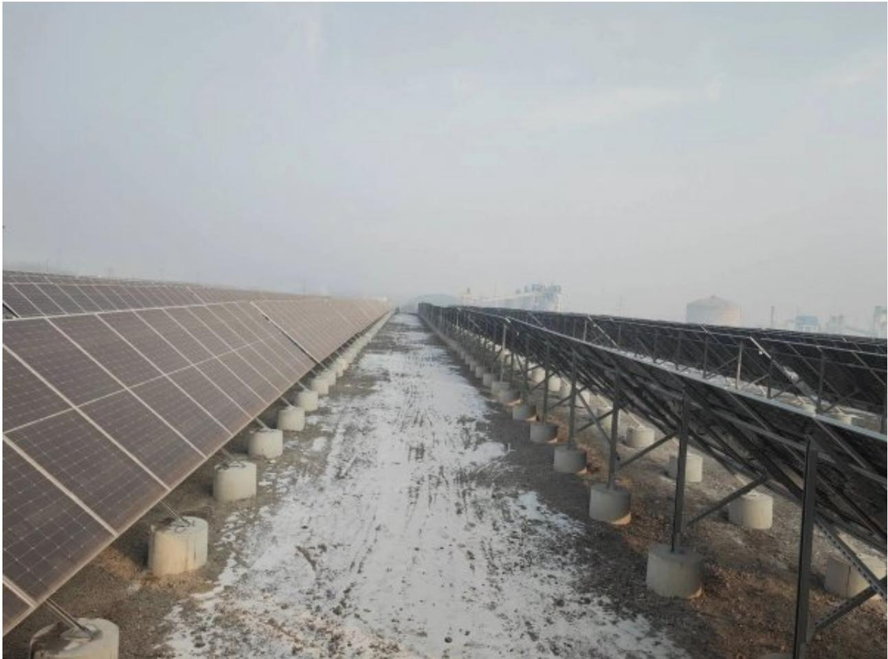
该项目于2023年9月开工建设，建设过程中，配重块全部采用冶金渣公司钢渣作为骨料，混合石子、混凝土等制作而成，有效实现了固废的综合利用。光伏支架全部由包钢集团锌铝镁产品加工制作而成，具有强度高、耐腐蚀性好等优点。项目设计过程中按照少人值班原则进行设计，电站进入稳定运行后，可实现无人值班、少人值守的方式智能化管理运营，努力打造管理规范、安全可靠、优质高效的新能源发电项目。
