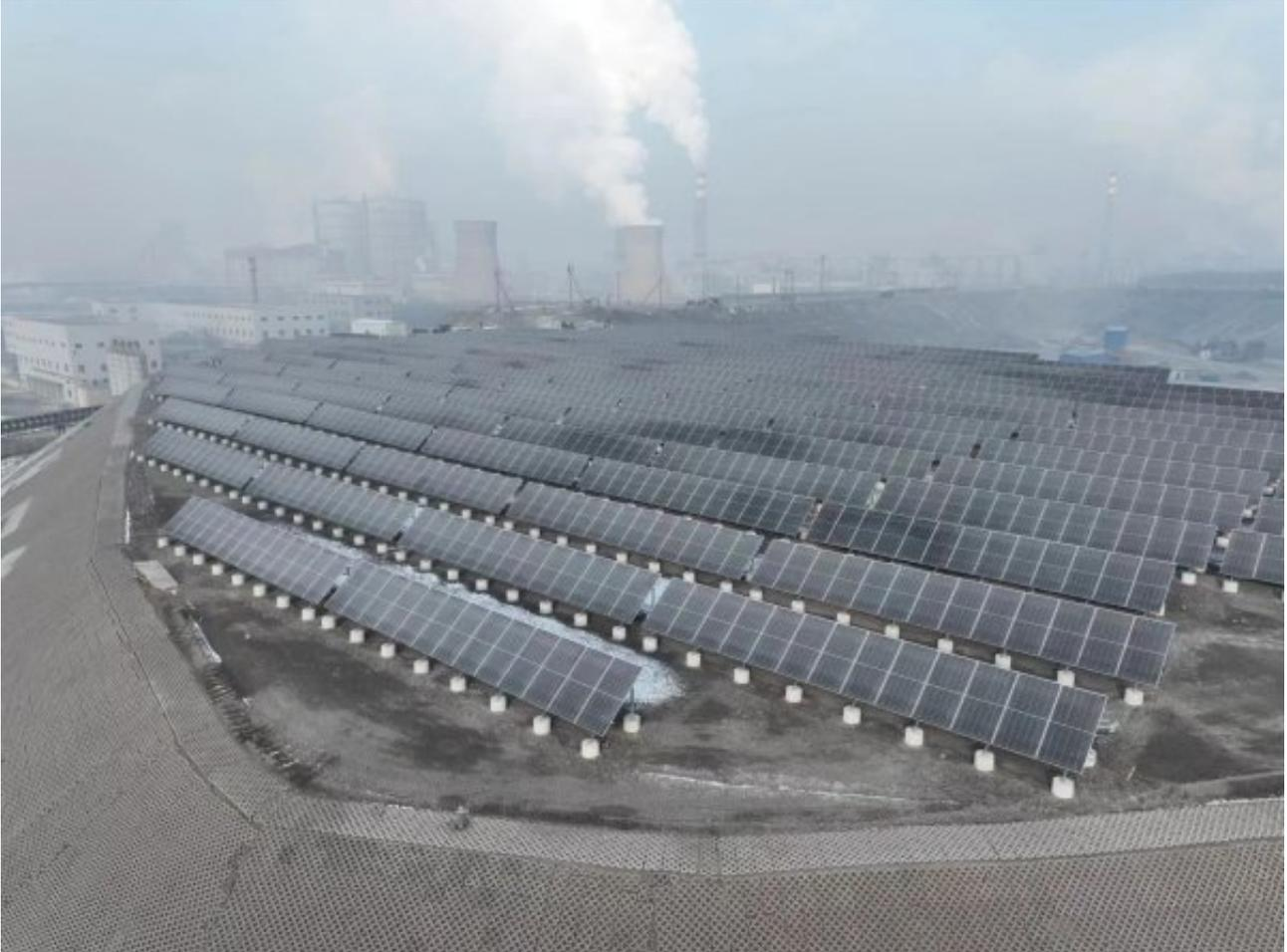
冶金渣公司市场化并网新能源5MWp分布式光伏项目是落实碳达峰碳中和决策部署，推动公司高质量发展的新能源产业重点项目，也是该公司首个新能源发电项目。项目建设于冶金渣公司铁渣山区域，占地面积约8万平方米，光伏发电系统装机容量5.0825MWp，配套3台箱变、19台逆变器、8710块575Wp单晶硅双玻太阳能光伏板，光伏组件阵列所发直流电经逆变器变成交流电并升压至10kV接入厂区10kV母线。
