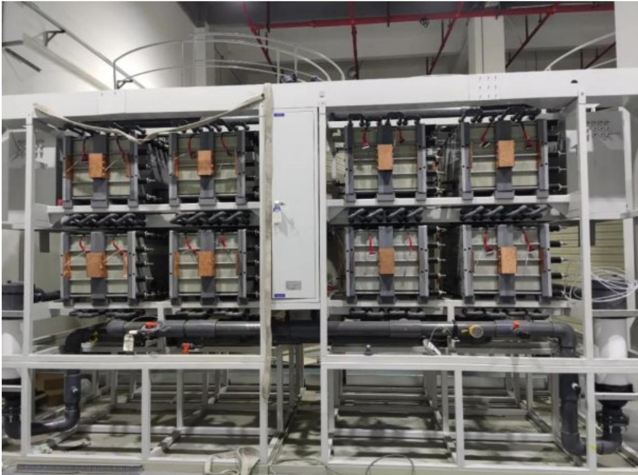
随着风电、光电等新能源上网电量不断增加，系统对长时储能的需求越来越多，全钒液流储能技术发展提速。能源技术研究院投入800万元研制了华南地区首个全钒液流储能电池系统，并在现代能源集团下属的科技园区成功进行示范应用。示范电站规模为500KW/2500KWh，项目占地256平方米，采用室内地面平层布置方式。系统包含2套储能单元，每套0.25Mw/1.25MWh。项目通过削峰填谷调节园区供电，年收益约60万元。通过该全钒液流储能电池系统的示范应用，可对全钒液流储能电池技术进行深入的实证研究，为下一步优化技术方案及推广应用此类新型储能技术提供有力的数据支撑。
