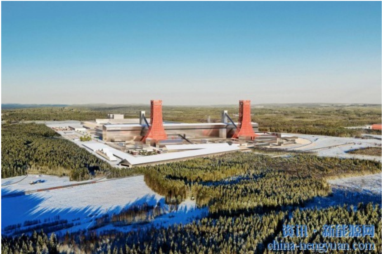
图为瑞典北部正在建设中的H2 Green Steel绿色钢铁厂的效果图
