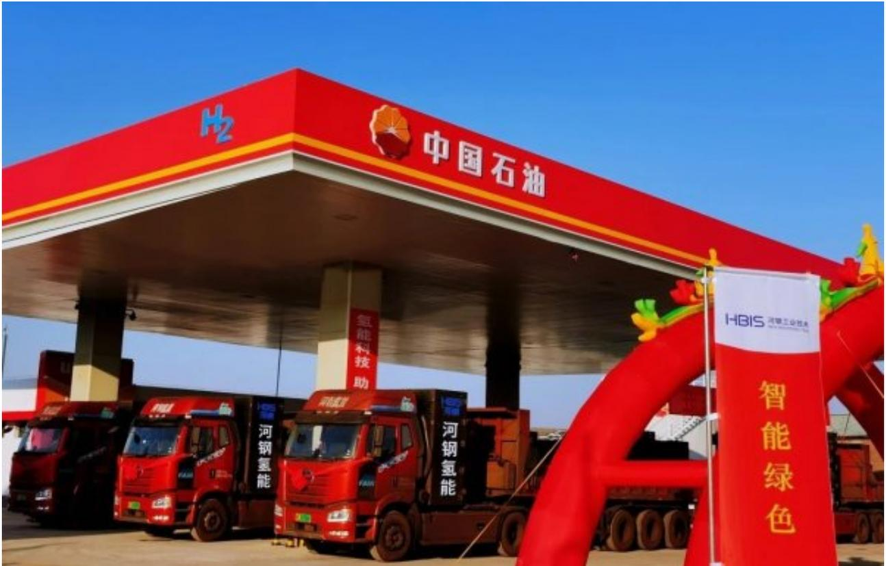
近日，河钢工业技术建设的河钢首座商业化氢油综合站正式投入试运营。新投入运营的商业化氢油综合站采用35MPa加氢工艺，拥有1000kg/d的加氢能力。
