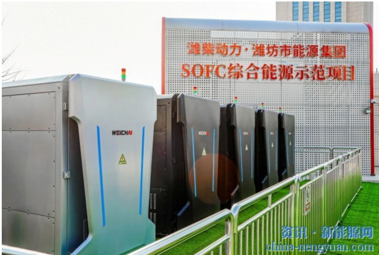
潍柴基于锡里斯(Ceres)技术制造了固体氧化物燃料电池。图：潍柴
