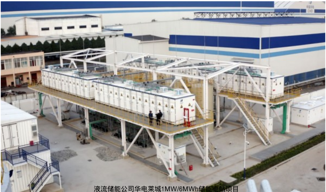
液流储能公司中核郯城1MW/4MWh全钒液流电池储能电站
