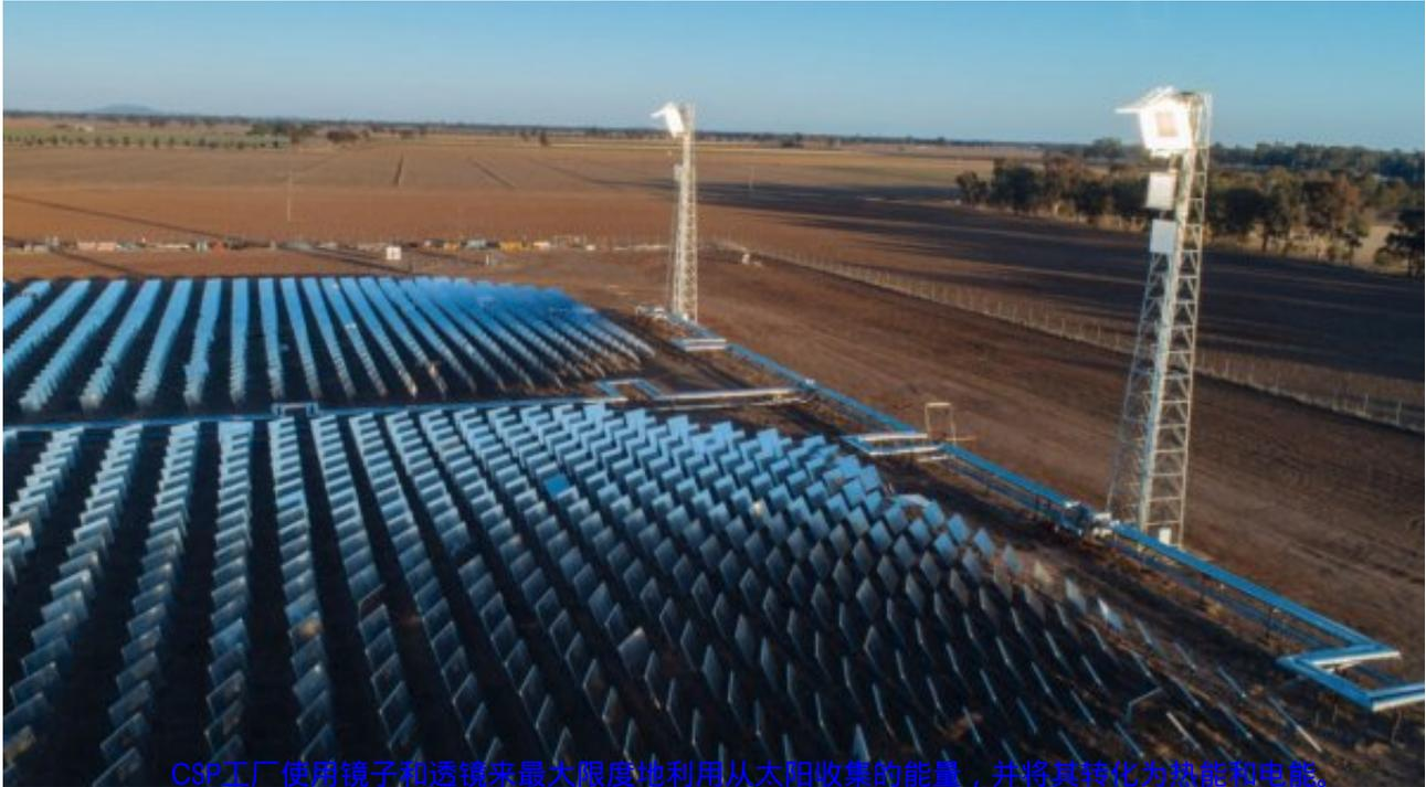
CSP工厂使用镜子和透镜来最大限度地利用从太阳收集的能量，并将其转化为热能和电能。
