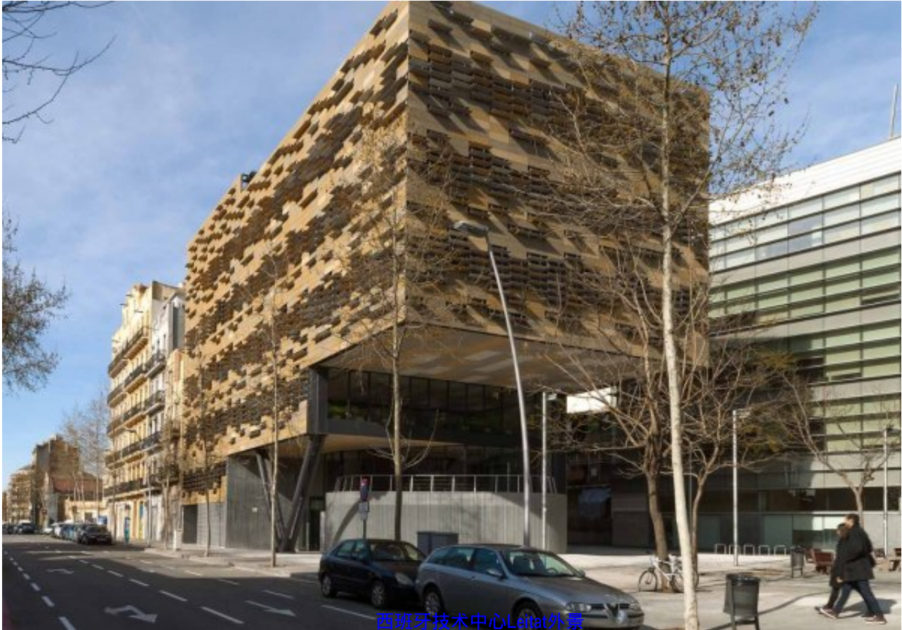
西班牙技术中心Leitat外观
