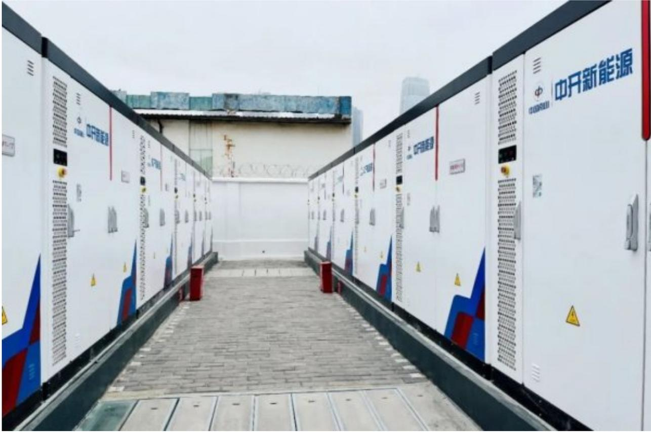
中开新能源赤湾储能示范项目装机容量共14.88MW/59.60MWh，设备分别为80台eBlock 745、4台升压一体机和1台EMS舱。场站占地面积约1500平方米。项目于2023年11月25日开工，2024年1月10日全容并网。项目预计运行15年，日均充放电约6万度。该项目可通过削峰填谷实现较好的经济收益，同时也响应了国家碳达峰、碳中和发展战略号召，具备较好的节能园区示范作用。
