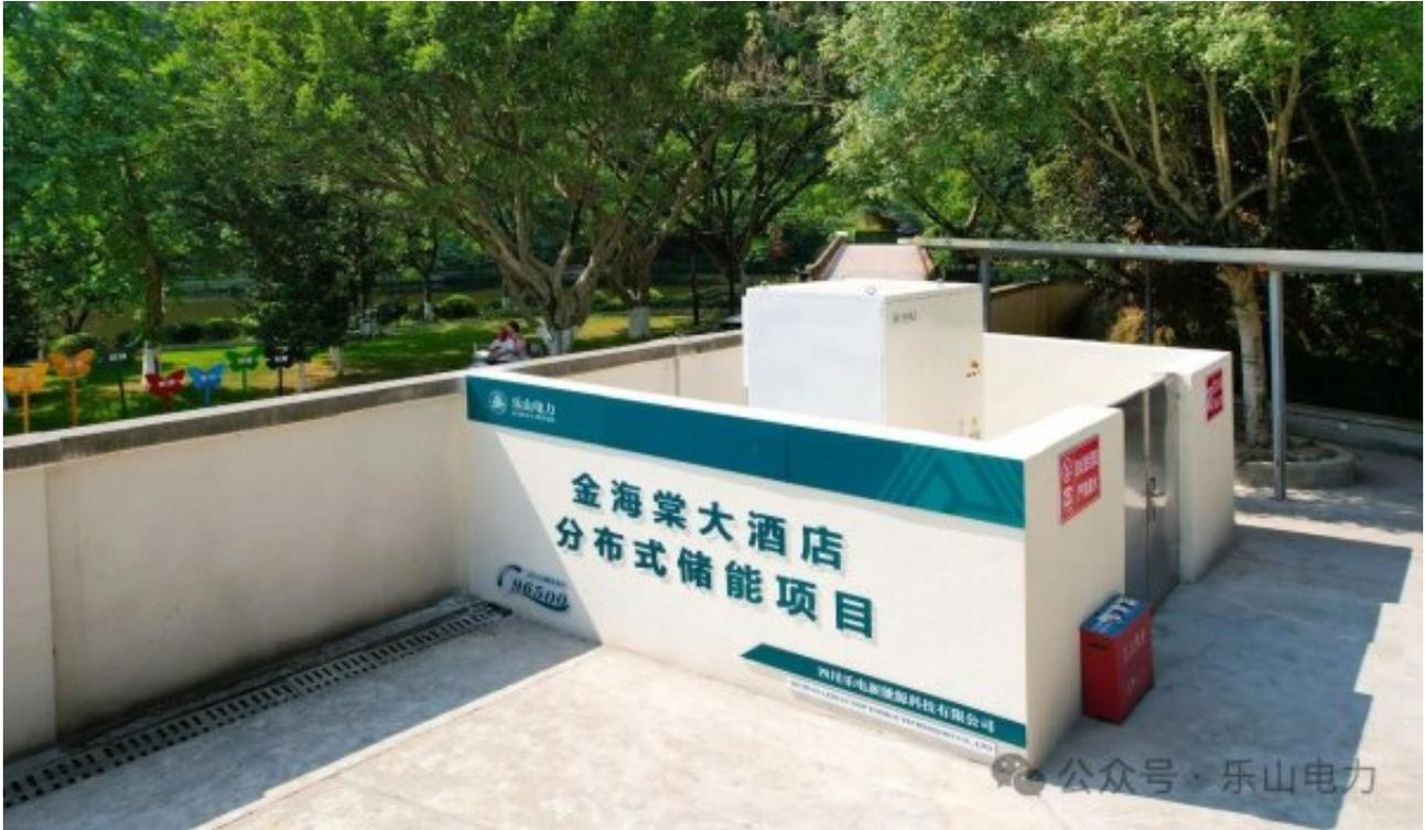
据了解，乐山电力金海棠储能项目作为四川省用户侧新型储能试点项目，于2023年7月正式投入运营，采用磷酸铁锂电池技术，是一台功率100千瓦、容量215千瓦时的分布式储能一体机。
