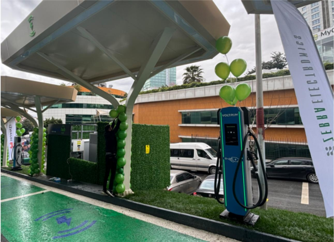
该站点配置一台华为600kW液冷超充主机，两台Zebra 500kW超快一体双枪终端，能同时满足4辆车的快速充电需求，助力新能源车主获得超快充体验。同时，作为超充方案的核心部件，华为数字能源提供的600kW液冷超充主机使用寿命可达到10年，可提供高效、快速、可靠的充电体验。该站顶部同时部署了光伏系统及优化器，并预留空间叠加储能系统，将实现优光储充一体化。作为头部能源电力公司，EnerjiSA还将为此充电站发布可再生能源发电厂发电的绿色能源认证。
