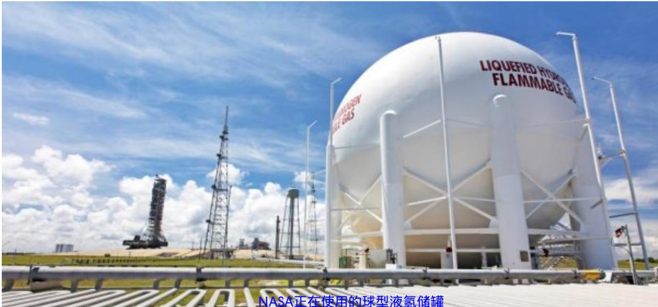
NASA正在使用的球型液氢储罐
