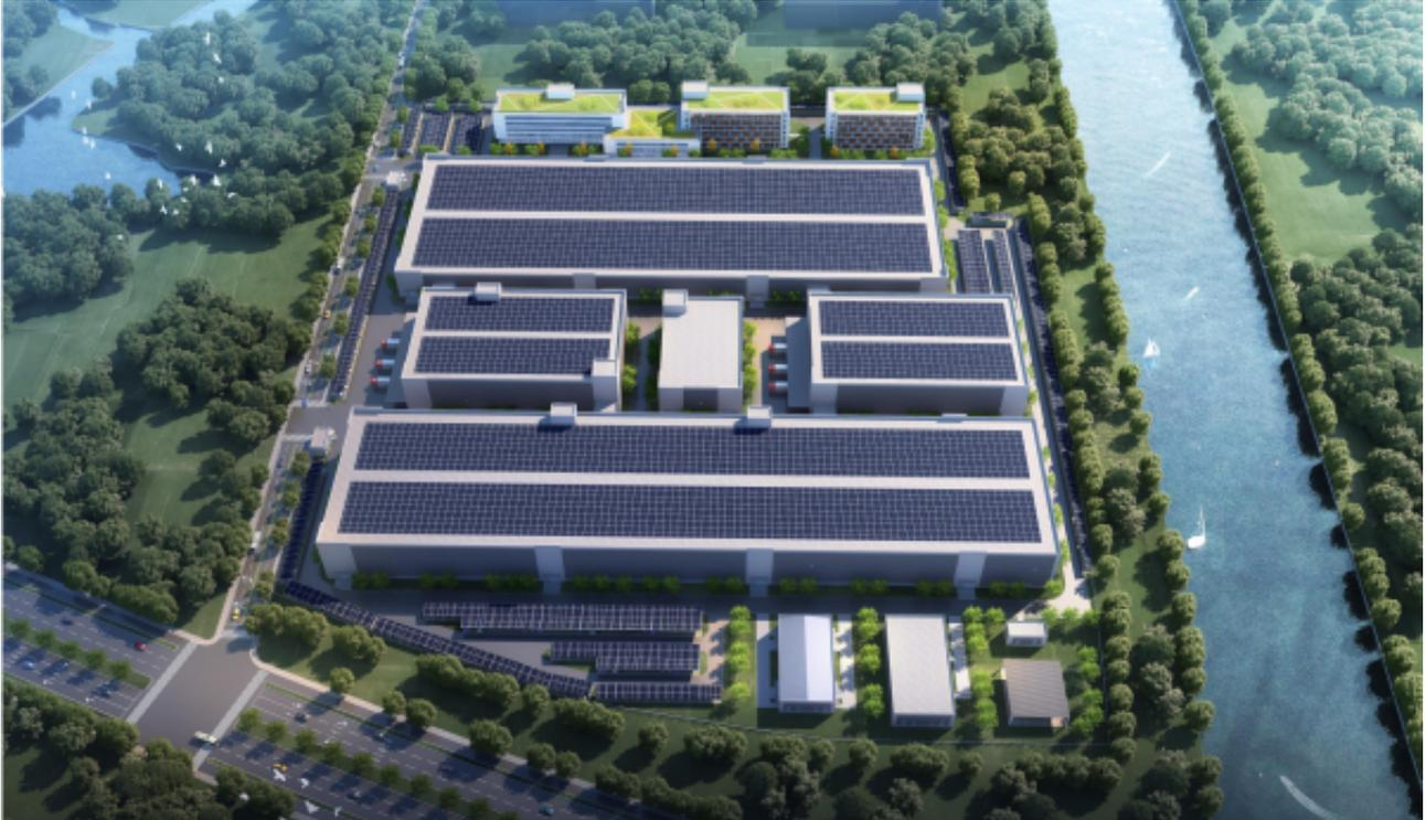
该项目位于浙江省湖州市南浔区，总建筑面积约23.22万平方米，并配套建设道路、给排水、绿化、停车位、围墙、供配电、消防等其他公用辅助工程。新增5条1GWH电池生产线，含各类高精定制设备约1500台（套），建成后预计年产能可达5GWh。
