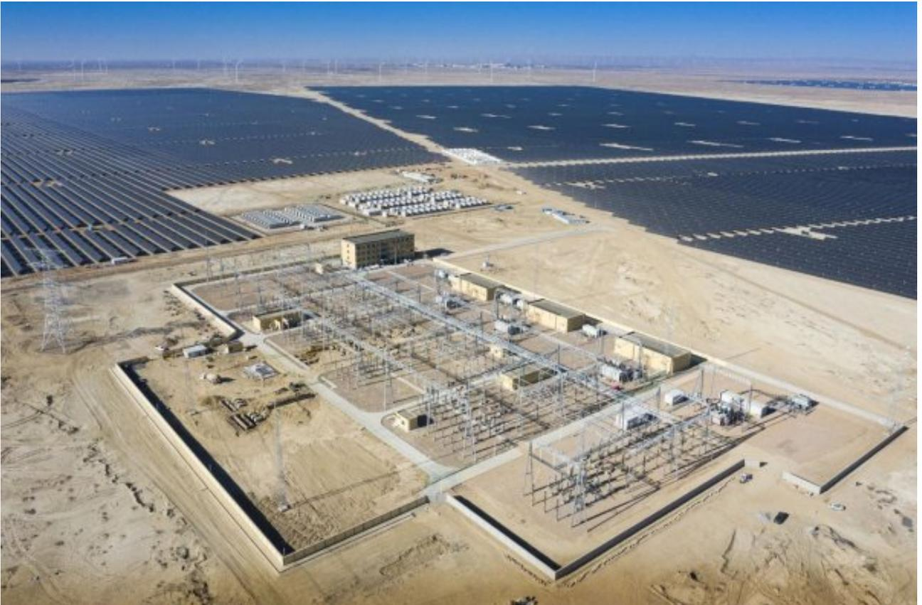
甘肃民勤县独立共享储能项目是甘肃首个构网型储能电站，可有效提高电网供电质量与新能源消纳能力。分两期建设200兆瓦/800兆瓦时共享储能电站1座，可支撑电网增加绿电消纳11.95亿度，节约标煤36.14万吨，减少二氧化碳排放99.41万吨、二氧化硫排放191.17吨、氮氧化物排放215.07吨、粉尘排放38.23吨。
