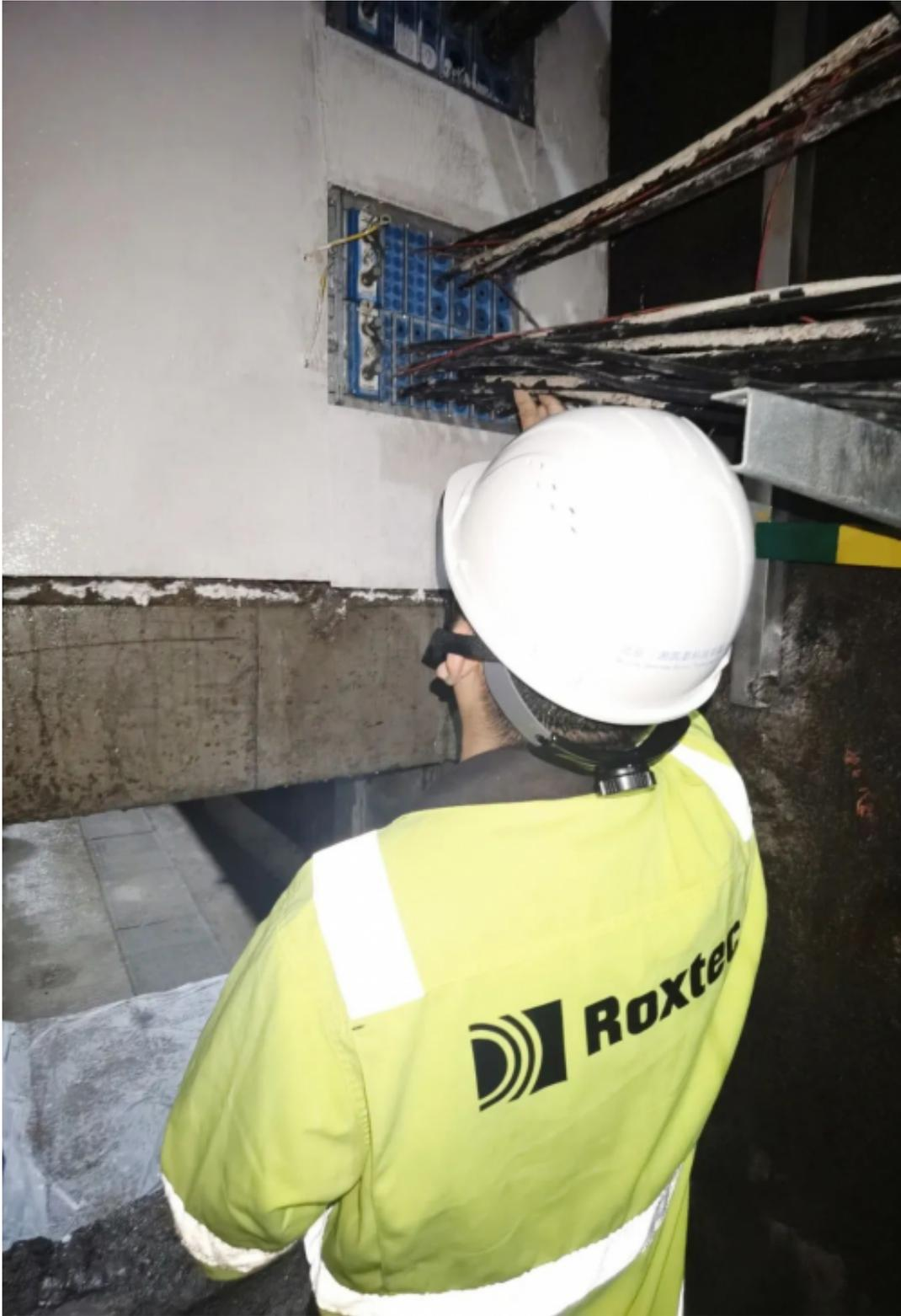
相比传统的封堵方式，Roxtec 密封系统拥有可持续扩展的灵活性，内置备用容量在未来任何需要升级或扩建的时候，都能够很轻松地打开并添加电缆，而无需任何备品备件或额外的安装工具。
