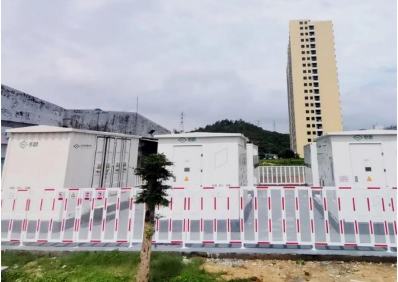
伯恩光学储能电站采用了德赛电池自研的280Ah电芯，从电芯、电池模块、电池簇、集装箱集成全部采用自主设计方案，具有高效、长循环、高安全等特性。此次电站建设装机容量达到5MW，储能容量达到10MWh，可有效降低用户的综合使用成本，大幅提升储能项目的投资收益回报率，满足一定规模的商业和工业设施的电力需求及备用等多种支撑服务。
