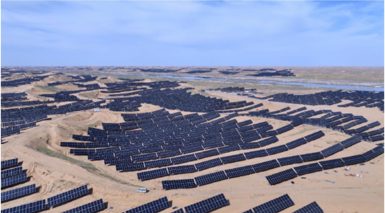
新疆米东项目位于乌鲁木齐市米东区北部沙漠，占地面积约20万亩，利用小时数1740h，年发电量60.9亿千瓦时，相当于300万户家庭一年的用电量。项目投运后，每年可节约原煤194.88万吨，减少二氧化碳排放量607.17万吨，减少烟尘约165.65万吨，减少氮氧化物约9.1万吨，对助力国家实现“双碳”战略目标，加快当地能源结构优化、推动电力市场建设具有重要的意义。
