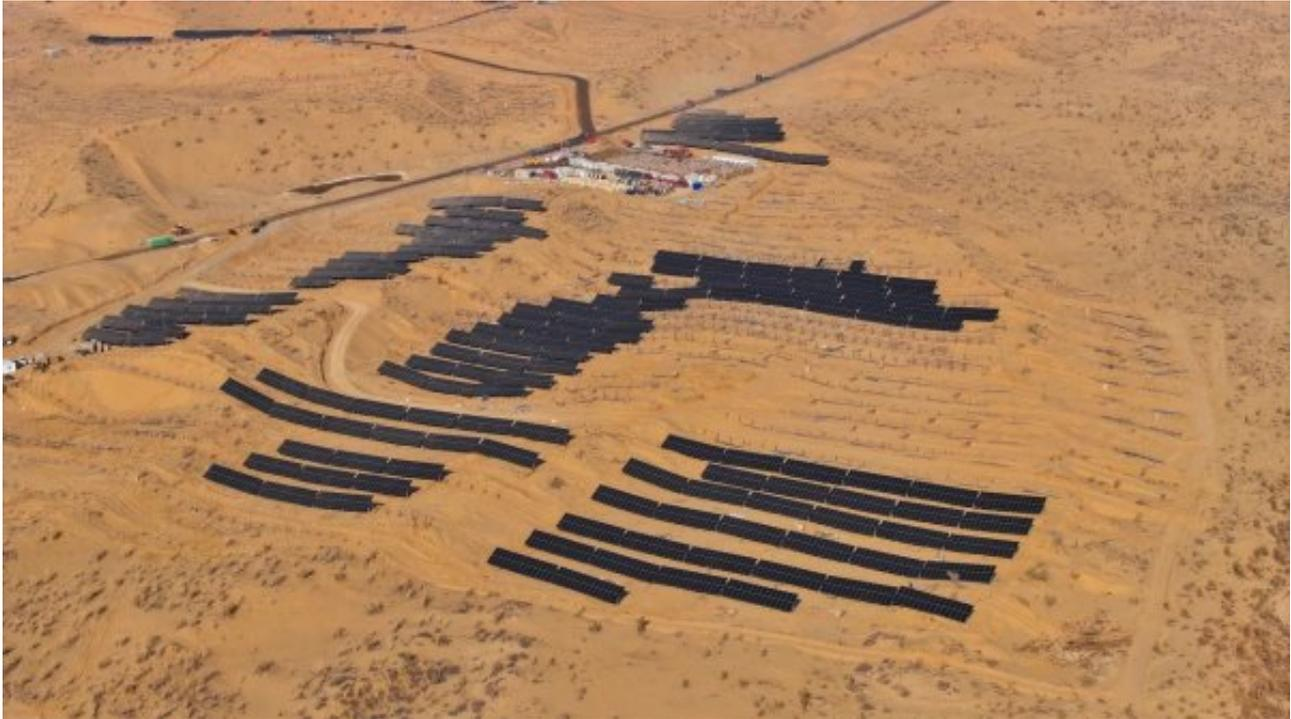
项目地处沙漠地区，场区覆盖范围广，存在沙漠地区特有的风沙大、土质松软等特点，自项目开工建设以来，打桩作业坍塌不成孔、运输车辆深陷沙地等施工、交通困难比比皆是。项目管理人员和作业队伍高度重视，根据特殊的地貌采取规范可行的施工方案，充分考虑光伏组件的抗风压能力、桩基的深度、选用材质等方面，从光伏支架、光伏基础、场内线路到施工方案，进行不断优化，从而应对沙漠的特殊环境。
