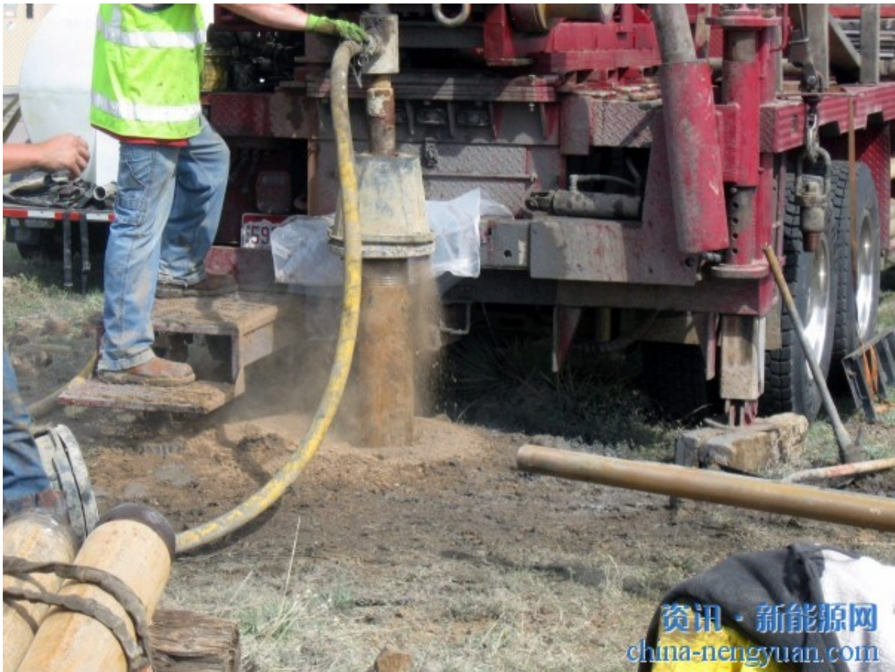
地热热泵系统的井芯钻探。(来源：Erin Anderson/NREL)
