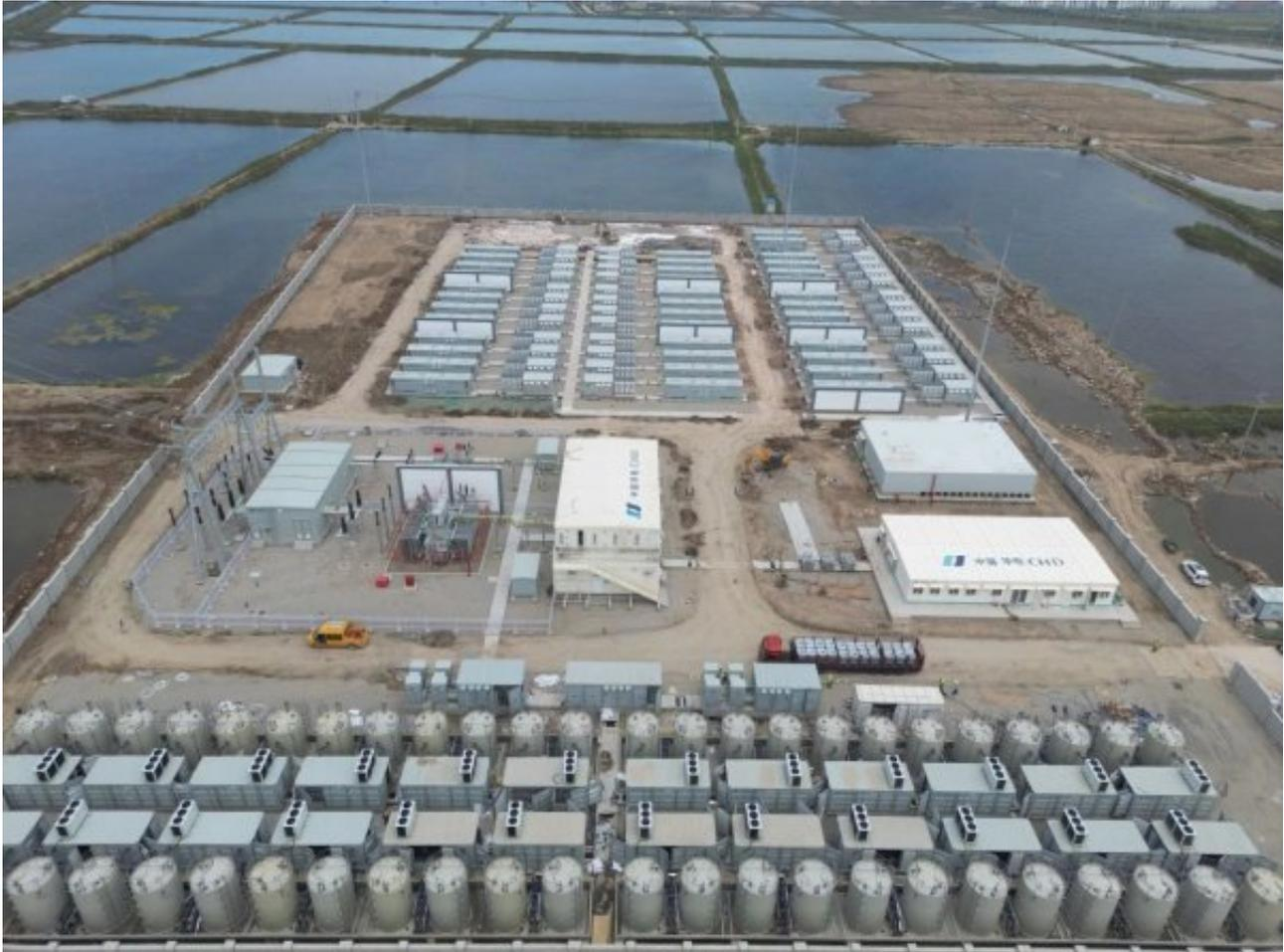
作为江苏省电力“715保供”的重点项目之一，该项目由华电江苏望亭发电厂开发建设和运营，创新性地采用磷酸铁锂储能与全钒液流储能相结合的混合储能模式，配套建设220kV/110kV升压站，装机规模20万千瓦/40万千瓦时，能够有效提升多元储能出力与负荷精准控制，提高电站的供电可靠性和稳定性。
