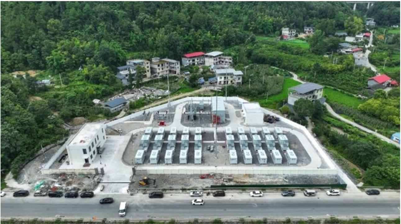
作为黔江区首座110千伏级储能设施，青杠储能电站采用了先进的磷酸铁锂电池技术，总装机容量达5万千瓦，储能总容量10万千瓦时。该电站坐落于正阳工业园区，被列为重庆市2024年电力迎峰度夏关键项目。项目核心配置包括一台63兆伏安的主变压器以及10套集成化的储能单元，每套单元集成了2台磷酸铁锂储能电池舱与4台储能升压变流一体机，形成高效稳定的能量存储和转换系统。
