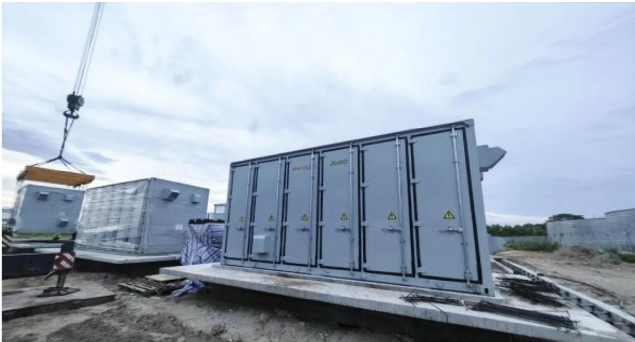
晶科能源蓝鲸液冷大型电站储能系统采用磷酸铁锂储能电池技术，Pack级温差小于2摄氏度，系统充放电效率高达94%，生命周期延长10%，可实现20年安全可靠运行。它兼容600V~1500V系统，配备五级安全保护，包括火灾探测、火灾报警和泄压、气溶胶灭火和水灭火，提高了产品的安全性和可靠性。支持肩并肩、背靠背排布，可使系统布局面积节省37%以上。
