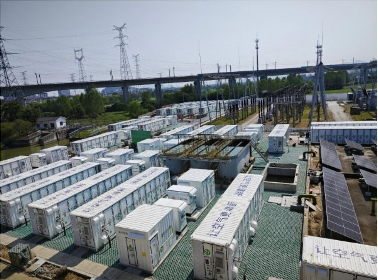
项目采取优化设计方式，结合电厂已有设施及线路，配合安装1台220kV分裂变压器（125MVA/2\*63MVA），采用液冷磷酸铁锂电池储能系统，共建设32套储能单元及升压变流一体机，每台套6.9MWH，是目前杭州地区投运容量最大的储能电站，也是杭州本年度首座投运的220千伏电网侧储能电站。
