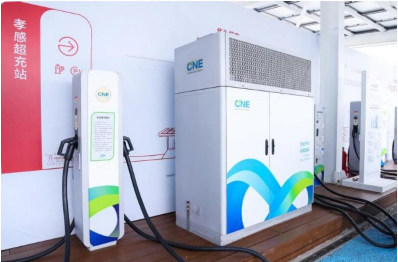
汉十高速全长434公里，日均车流量达2.5万辆。该综合能源示范线沿线7对服务区，共配置乘用车超充站7座，商用车超充站6座，其中每站设有一台600千瓦液冷主机，2路超充终端，10路快充终端，最快可实现“一秒一公里”的补能速度。该示范线打造了高速路网新能源基础设施建设的湖北样板，助推“汉孝随襄十”向具有国际竞争力的万亿元
