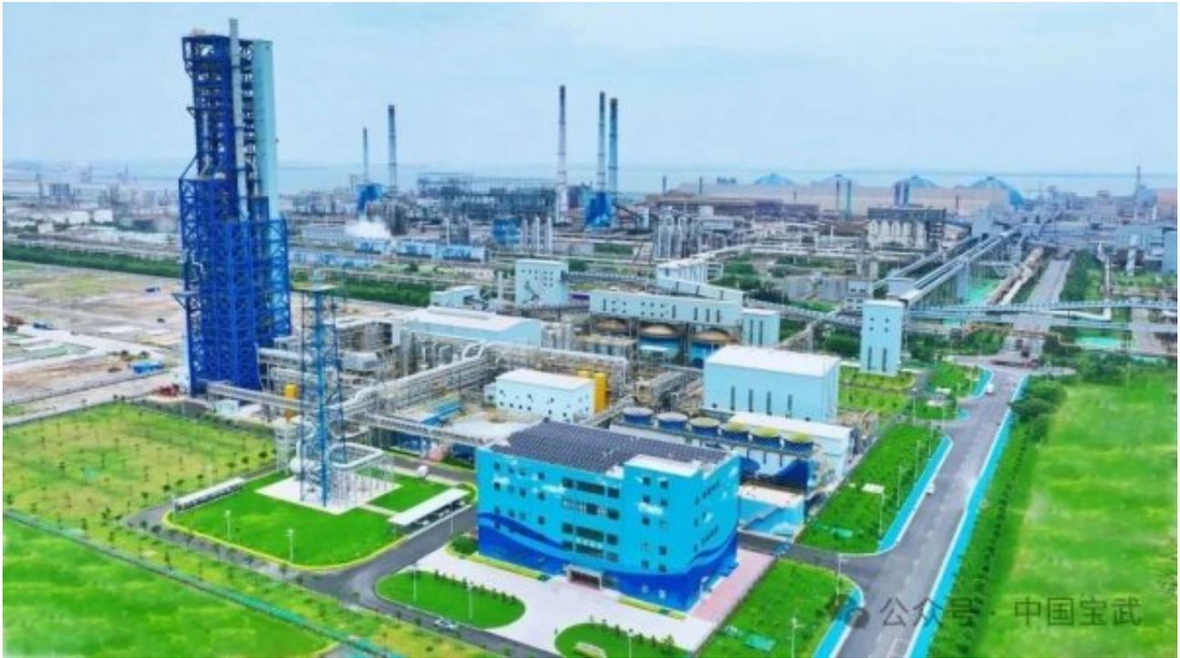
8月22日上午8时，国内首套百万吨级氢基竖炉实现168小时连续满负荷生产，顺利通过周达产功能考核，并成功验证了高氢（70%氢气含量）冶炼条件，标志着宝钢股份湛江钢铁在勇攀科技高峰，坚定不移走绿色低碳发展之路上又迈出了坚实的一步，对中国钢铁工业探索零碳绿色发展具有重要意义。
