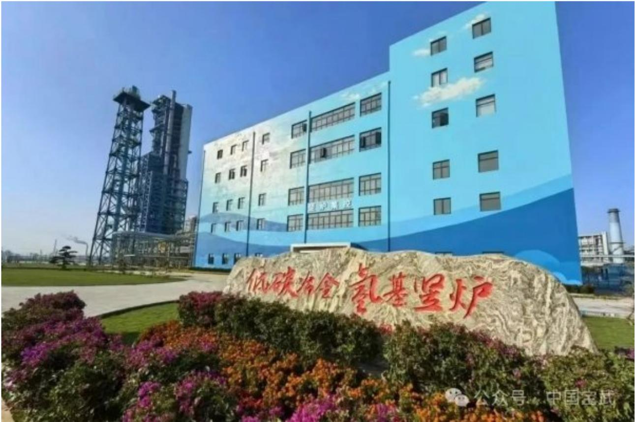
湛江钢铁氢基竖炉是在国外前沿直接还原铁工艺技术的基础上，开发出的适合本国资源及能源特点的竖炉生产工艺系统。该系统可同时使用焦炉煤气、天然气、氢气作为原料气，比例可灵活调整，具备从富氢、高氢至全氢还原的试验条件。同时，该系统也因其技术的创新性、生产的复杂性和没有可供借鉴的先例，让氢基竖炉技术团队开展氢冶金技术探索充满了挑战。
