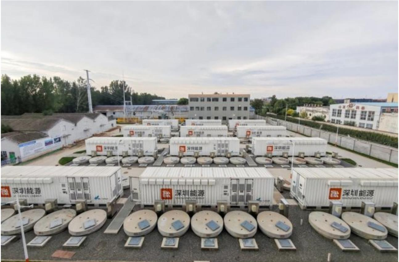
该项目主要建设30兆瓦飞轮储能调频电站及附属配套工程，由12套飞轮储能调频单元组成，每套单元包含10台高速磁悬浮飞轮相关辅助、驱动与控制系统以及升压变流一体机预制舱。
