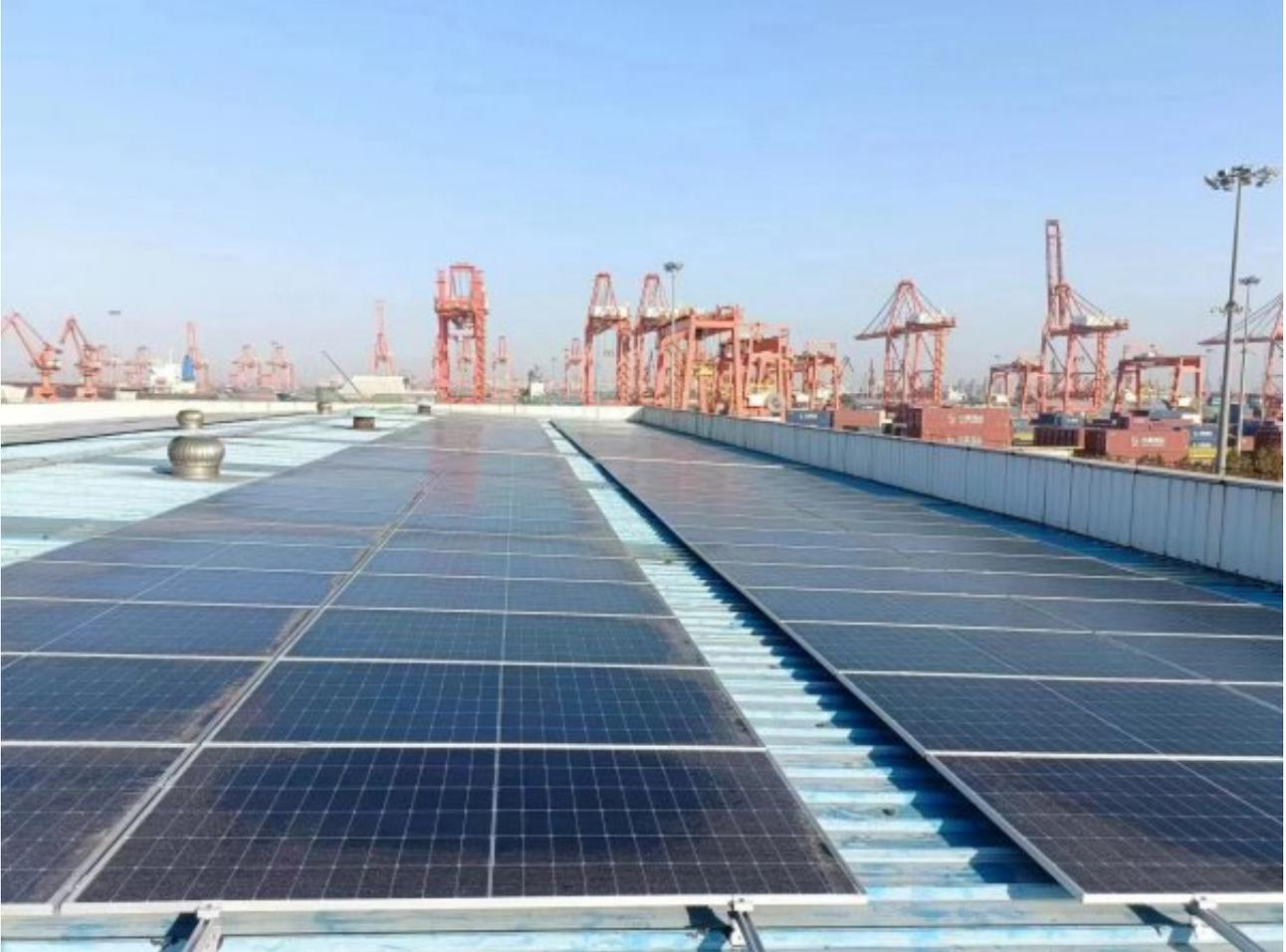
该项目位于唐港集团津唐集装箱公司，利用该公司机修车间、拆装箱库、消防站、海关库等5个大型建筑物屋顶铺设光伏板，覆盖面积合计约1.8万平方米，总装机功率2.3兆瓦，年发电量预计可达260万度，相当于每年节约标准煤320吨、减少二氧化碳排放2700吨，可满足1个集装箱泊位70%的用电需求。
