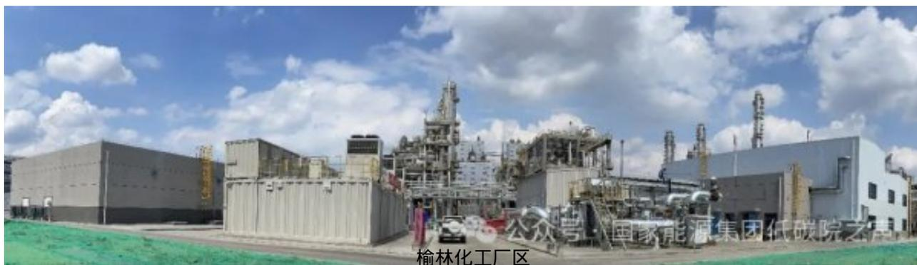
为确保项目按期试运，自2023年9月正式动工以来，项目团队恪守低碳院和属地各项安全管理规定，高标准、高质量完成了示范工程建设任务。试车期间，低碳院项目团队与榆林化工、龙源环保及各供应商通力配合，充分准备，牢牢守住试车安全底线，克服制氢系统调试难度大、安全风险高的困难，攻克储热模块泄漏量大、电加热丝极板绝缘密封等难关，最终液流电池完成充放电测试、储热单元成功产出蒸汽、电解水单元产出合格氢气，实现项目一次试车成功，为后续开展“光伏+储能+制氢+储热+智能微电网”联合试运行奠定了坚实基础。
